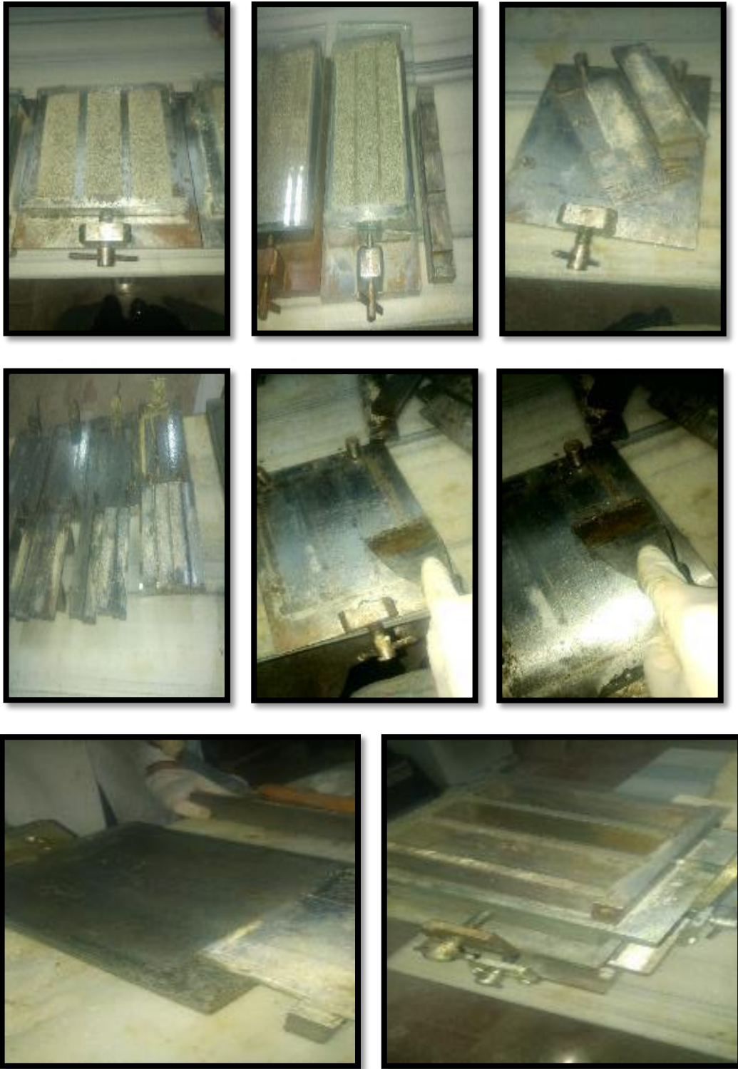
Şekil 7.3 Kalıpların sökülmesi ve temizliği
