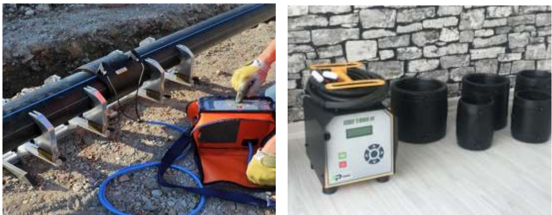
Şekil 3.7 Elektrofüzyon kaynak makinesi
