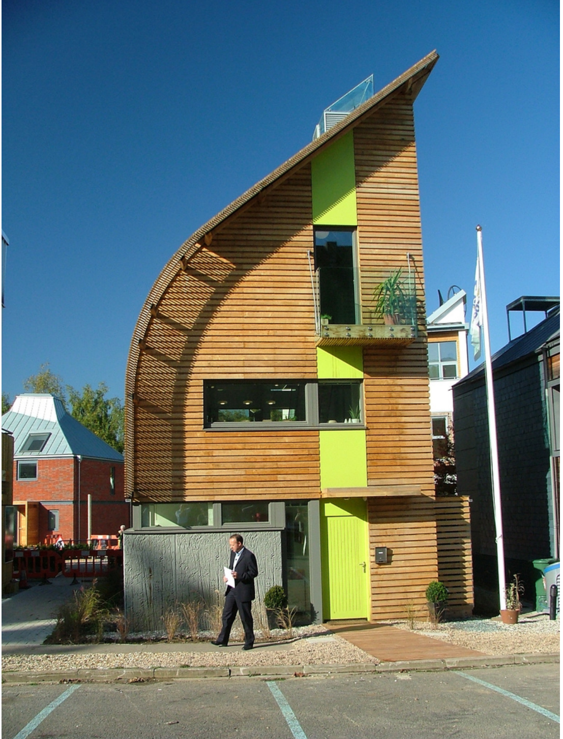
Şekil. 47. Kingspan Ön cephe (Guzowski, 2010)
