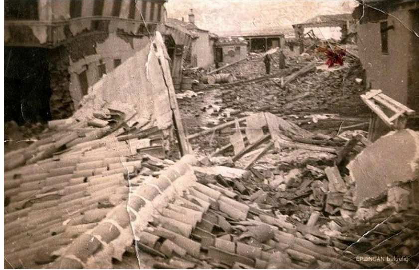
Şekil 4.35 27 Aralık 1939 Erzincan Depremi hasarı (AFAD,2019)
