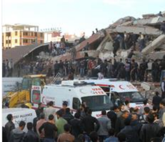
Şekil 4.50 23 Ekim 2011 Erciș Depremi hasarı (AFAD,2019)
