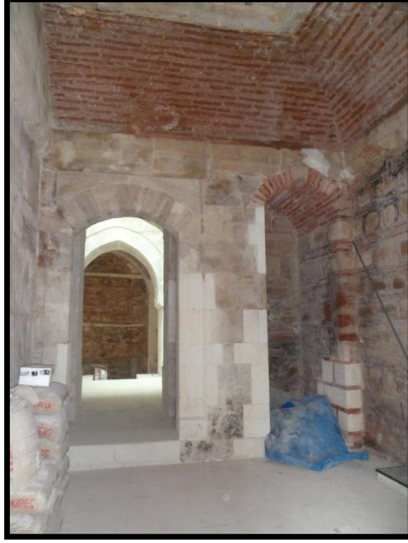
Foto.20. Hadım Hasan Paşa Medresesi-Giriş Bölümü (2011)
