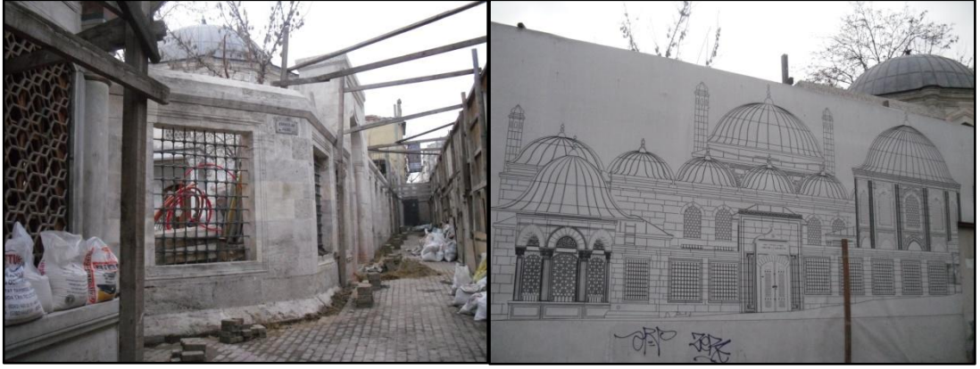
Foto.6. Gazanfer Ağa Medresesi-Restorasyon Çalışması (2011)
