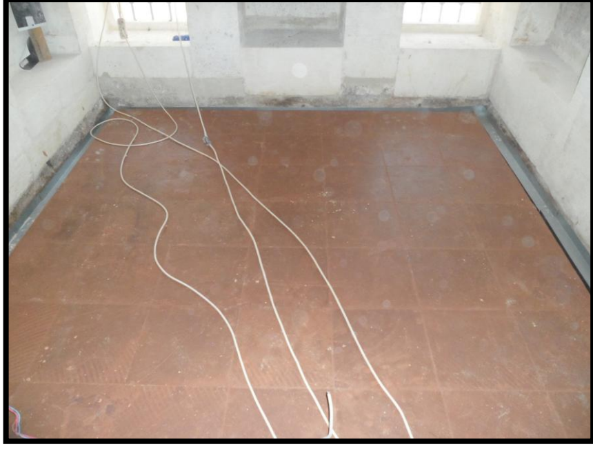
Foto.33. Hadım Hasan Paşa Medresesi-Taban Tuğlası (1K03) (2011)
