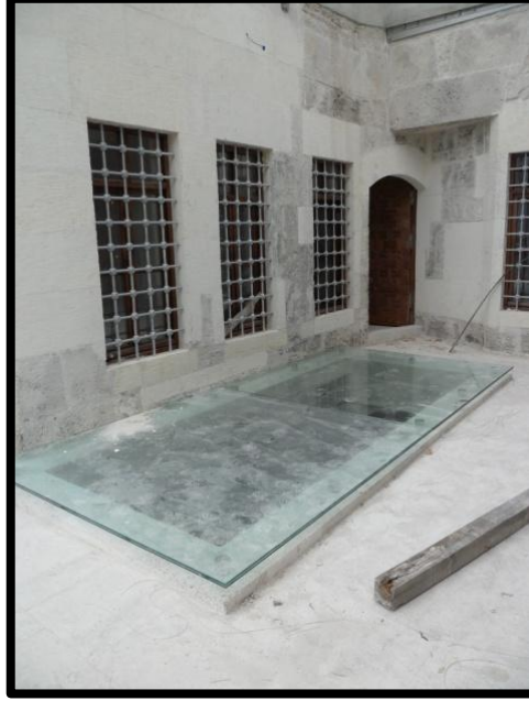
Foto.74. Hadım Hasan Paşa Medresesi-Yeni Malzeme-Cam (2011)
