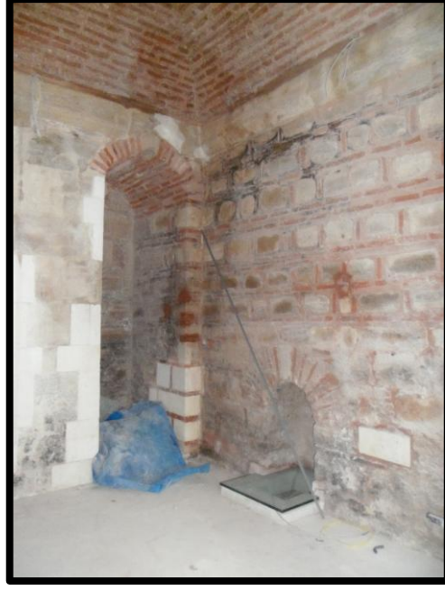
Foto.25. Hadım Hasan Paşa Medresesi-Zemin Kat (2011)
