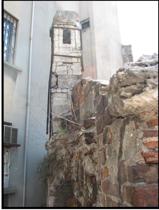
Foto.46. Hadım Hasan Paşa Medresesi-1. Kat Bozulmalar (2007) (Kaynak: Tures Turizm Planlama ve Restorasyon San. Tic. Ltd. Şti.)
