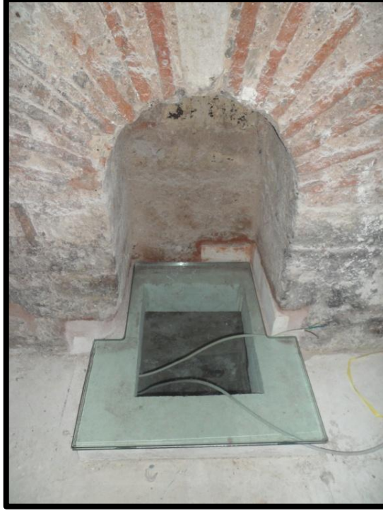
Foto.76. Hadım Hasan Paşa Medresesi-Yeni Malzeme-Cam (2011)
