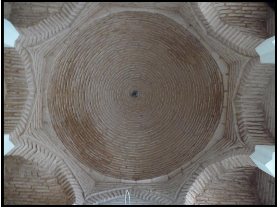
Foto.64. Hadım Hasan Paşa Medresesi-Kubbe Restorasyon Sonrası (1K03) (2011)
