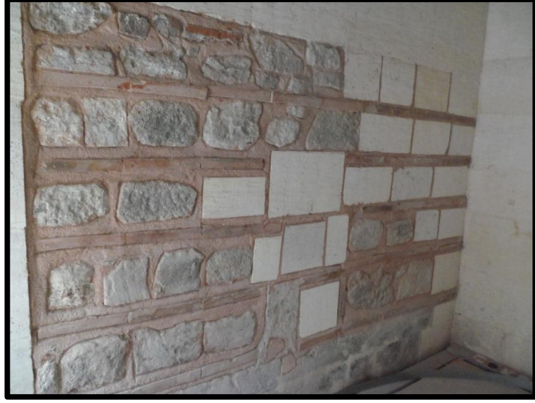
Foto.68. Hadım Hasan Paşa Medresesi-Malzeme Çözümü (2011)
