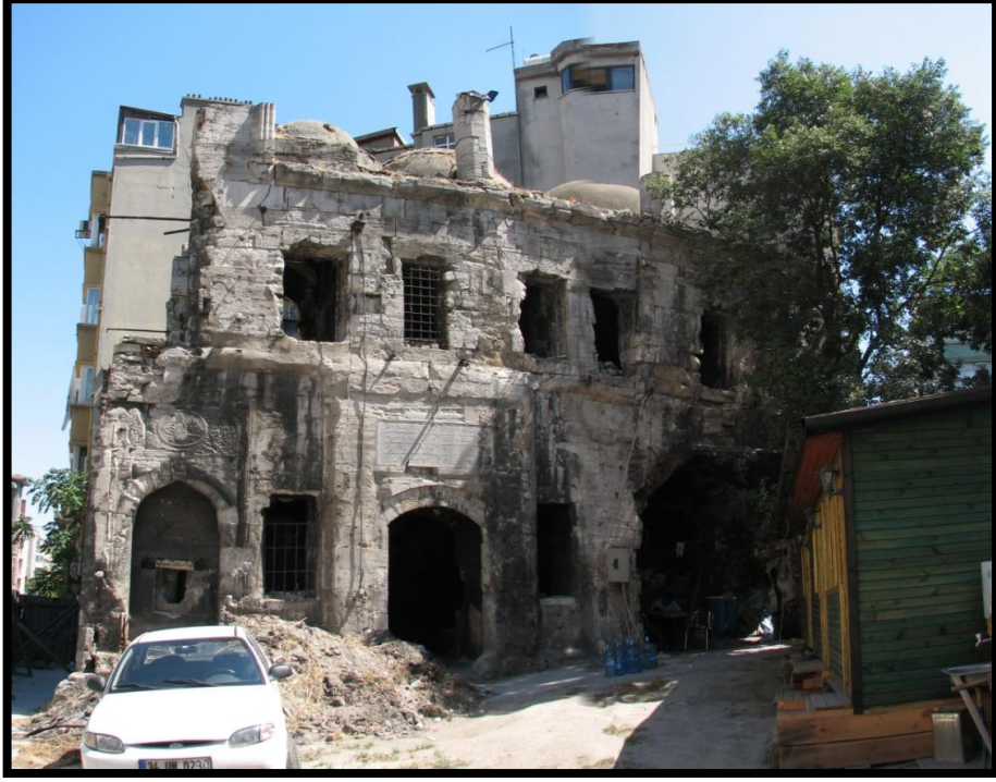
Foto.37. Hadım Hasan Paşa Medresesi-Kuzeybatı Cephesi (2009) (Kaynak: Tures Turizm Planlama ve Restorasyon San. Tic. Ltd. Şti.)
