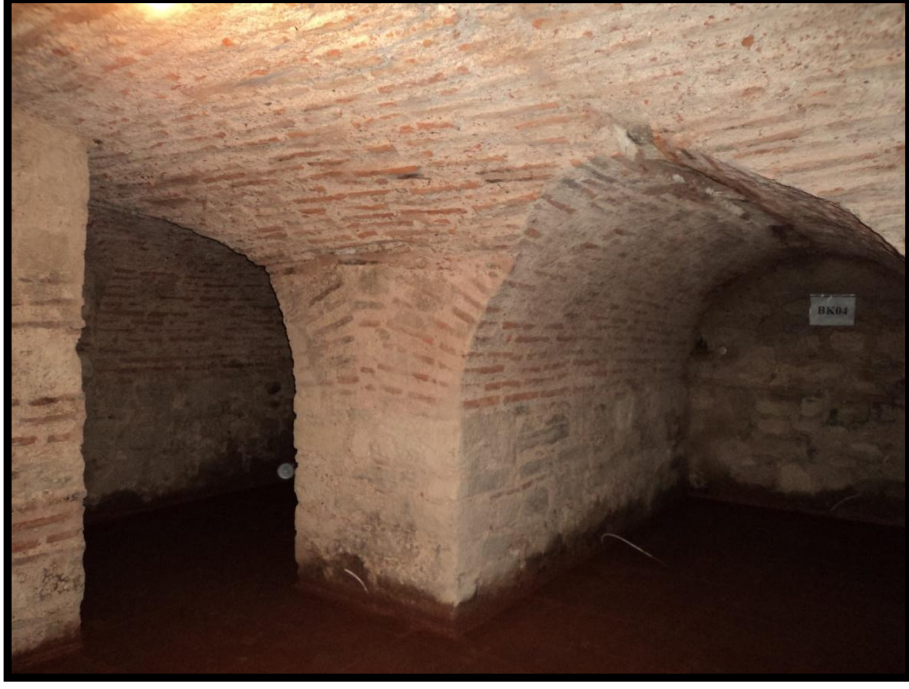
Foto.24. Hadım Hasan Paşa Medresesi-Bodrum Kat (2009)
