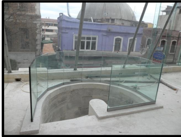
Foto.75. Hadım Hasan Paşa Medresesi-Yeni Malzeme-Cam (2011)
