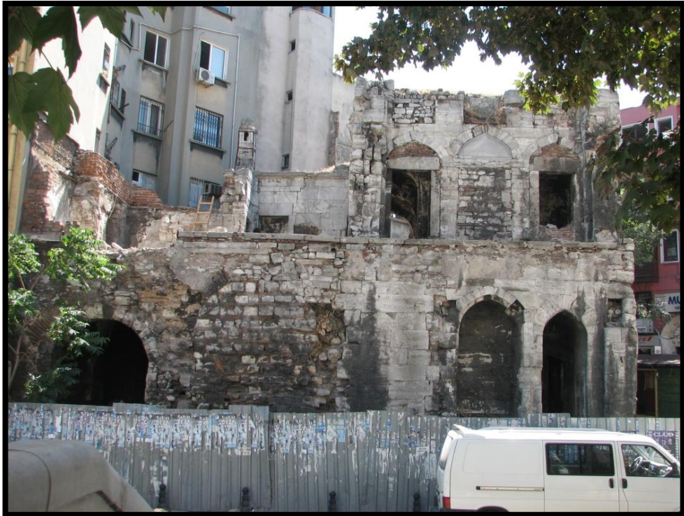
Foto.38. Hadım Hasan Paşa Medresesi-Kuzeydoğu Cephesi (2009)
