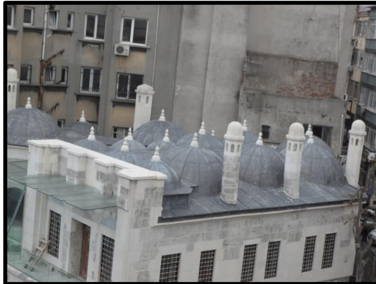
Foto.71. Hadım Hasan Paşa Medresesi-Kubbeler (2011)
