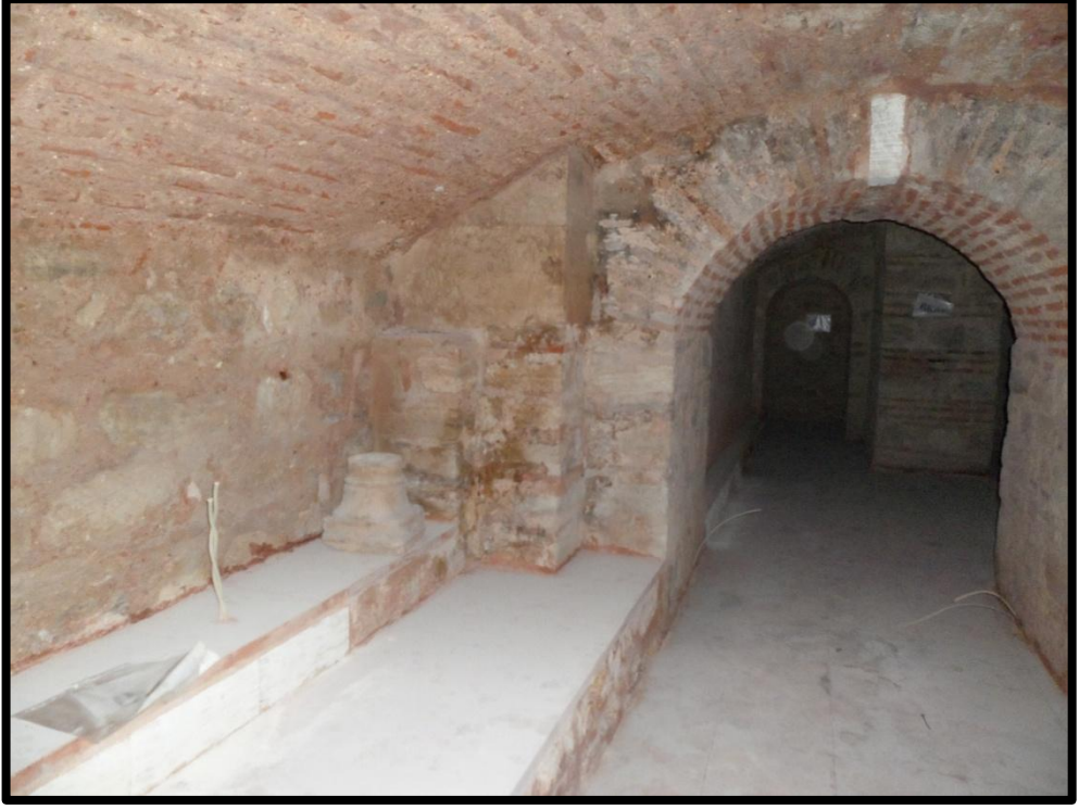
Foto.22. Hadım Hasan Paşa Medresesi-Bodrum Kat (2011)
