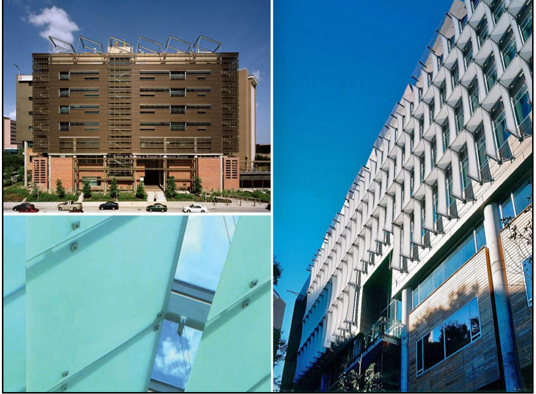
Şekil 68: Yapı Kabuğu ve Çatısındaki Doğal Aydınlatma Elemanları – UT Hemşirelik Okulu ve Öğrenci Merkezi [140]
