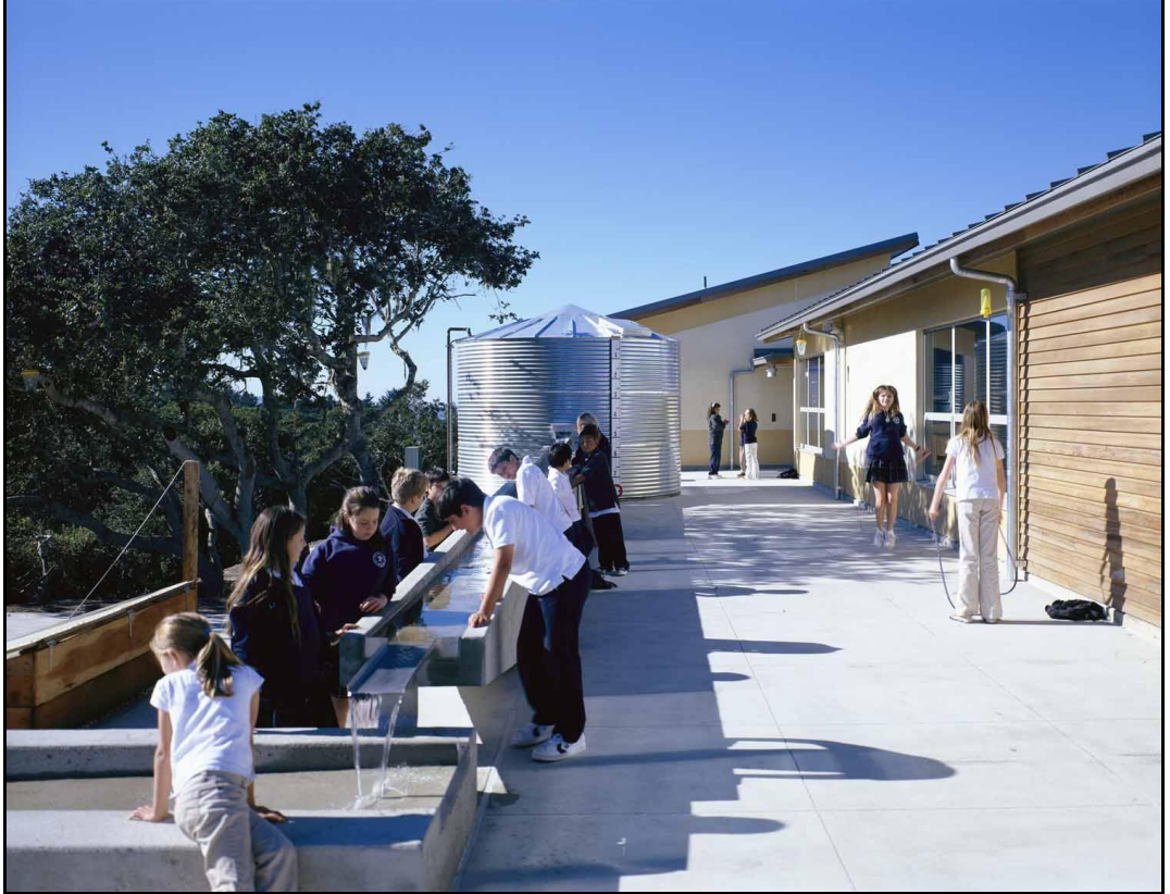
Şekil 81: Yağmursuyu Toplama Sistemi – Chartwell Okulu [143]
