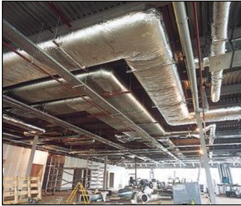
Şekil 37: HVAC dağıtım elemanlarının yalıtımı [84]
