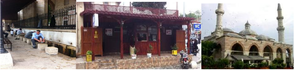
Resim 5.19: Eski Cami Orjinalliğini Koruyan Giriş Kapıları, Cami Revakları ve Tuvaletler
