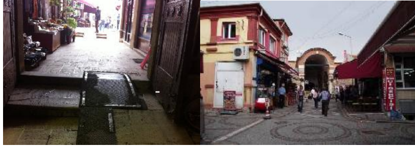
Resim 5.26: Ali Paşa Çarşısı'nda Erişilebilir Durumda, Düzayak Olan Kapı Kaynak: Çenet Arşivi, 2013 E.T: 13.10.2012
