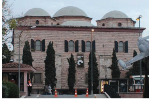
Resim.5.142. Restorasyon sonrası Lengerhane-i Amire'nin cephe görünümü
