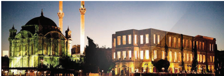
Resim.5.268. Restorasyon sonrası. 'The Marmara Esmâ Sultan' cephe görünümü
