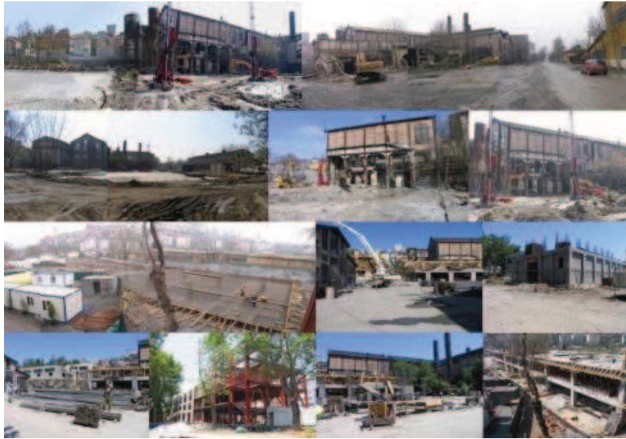
Resim.5.91. Silahtarağa Elektrik Santrali dönüşürken
