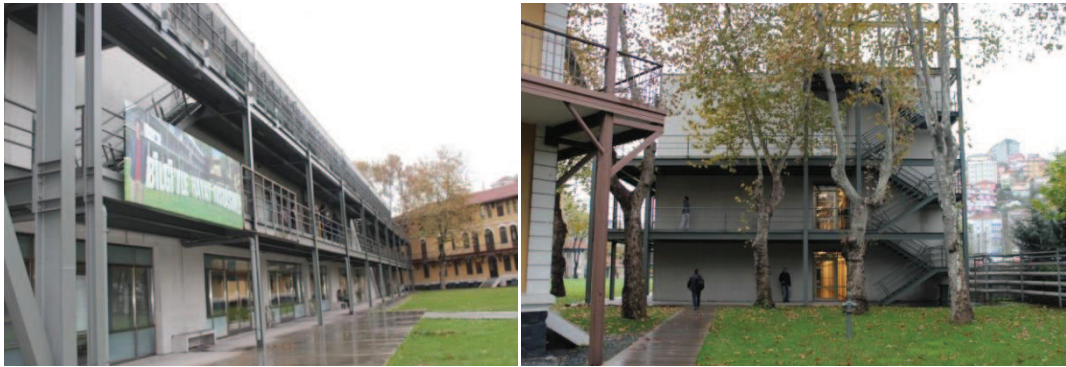
Resim.5.105. Yerleşkeye eklenen eğitim yapıları
