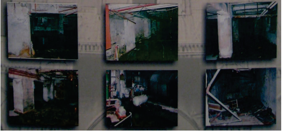
Resim.5.25. Restorasyon öncesi bodrum katının görünümü
