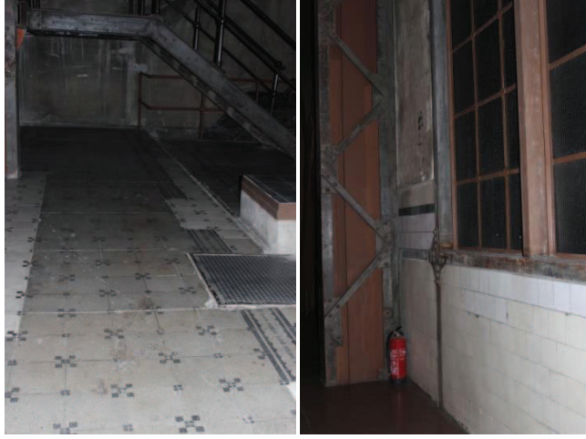
Resim.5.128. Kontrol odası zemin ve duvar döşemeleri
