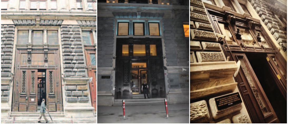
Resim.5.197. Yapının restorasyon öncesi ve sonrası giriş kapısının görünümü
