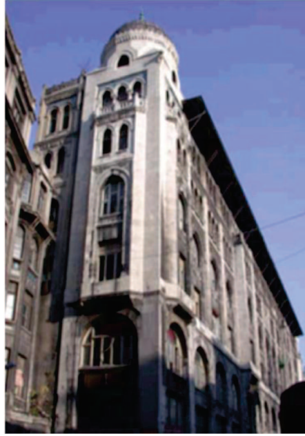
Resim.5.1. Restorasyon öncesi IV. Vakıf Hanı'nın cephe görünümü
