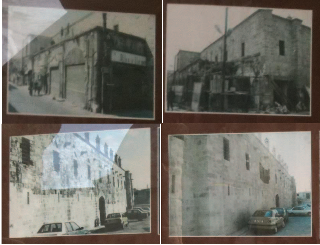
Resim.5.337. Büyük Han'ın restorasyon öncesi cephe görünümleri (Büyük Han Kültür Merkezi bilgilendirme panosu)
