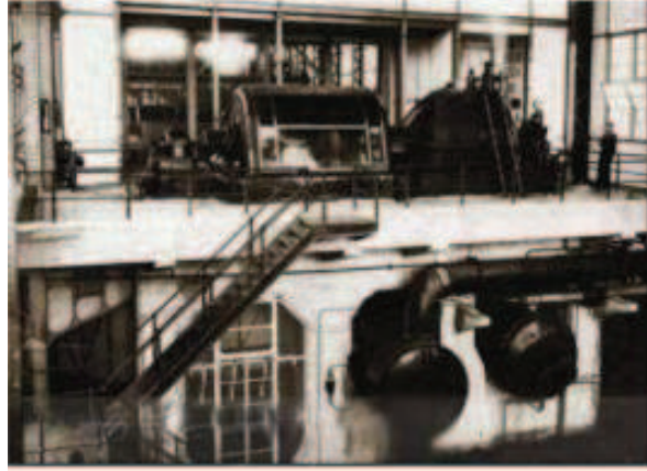
Resim.5.86. 2 numaralı makine dairesinde yer alan türbin-jeneratör grubu platformunun görünümü
