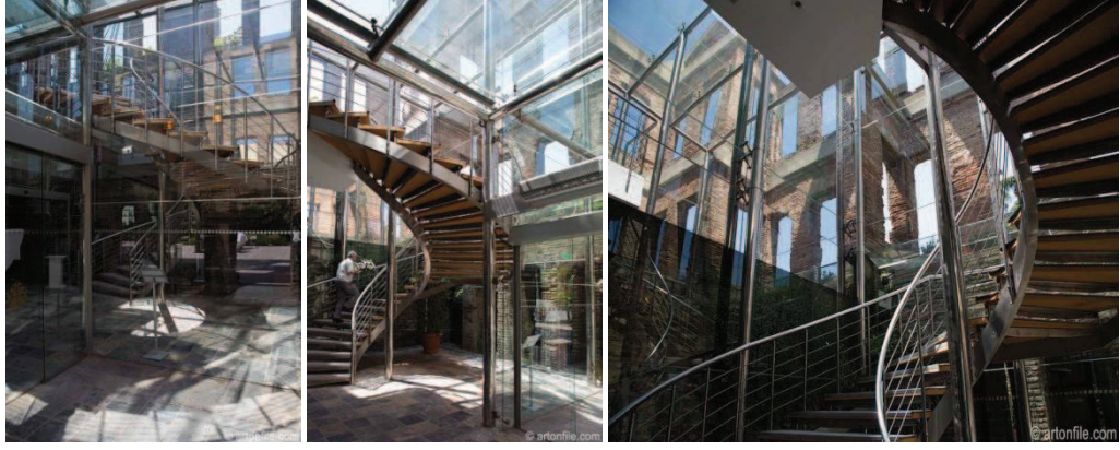
Resim.5.278. The Marmara Esma Sultan, çelik konstrüksiyonlu merdiven
