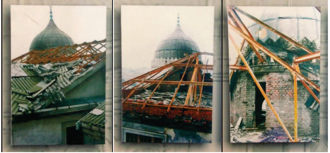
Resim.5.21. Restorasyon öncesi çatı katının görünümü
