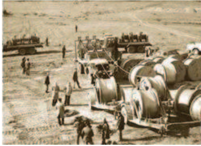
Resim.5.67. Elektrik hatlarının çekilmesi
