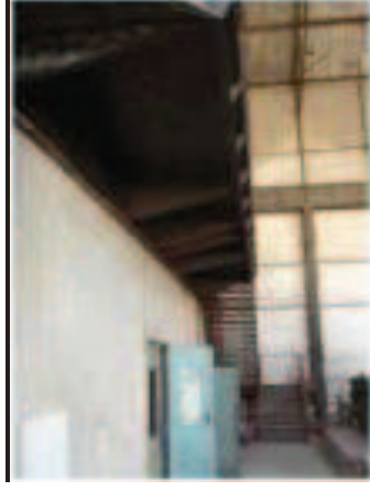
Resim.5.123. Dönüşüm sırasında kaldırılıp yerine gezi platformu bağlanan merdivenin görünümü (DS Mimarlık, Kaşlı, 2009)
