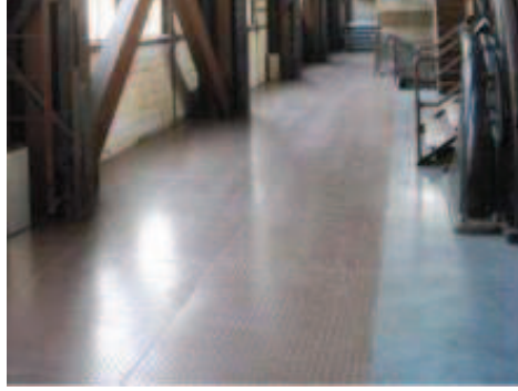
Resim.5.129. Türbin-jeneratör grupları etrafındaki yeni zemin döşemeleri (B. Kaşlı arşivi)
