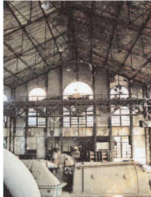
Resim.5.90. Restorasyon öncesi iç mekan (Köksal, 2004)
