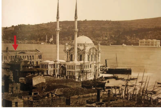
Resim.5.265. Esmâ Sultan Yalısı yangın öncesi görünümü
