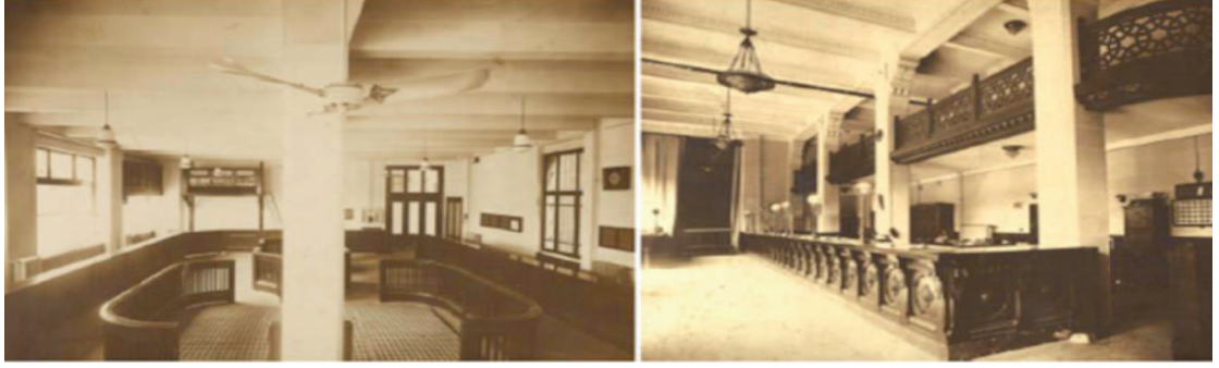
Resim.5.28. Sebah-Joallier'in çektiği fotoğraflarda IV. Vakıf Han'ın Restorasyon öncesi iç mekan görünümü
