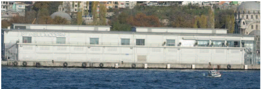
Resim.5.246. İstanbul Modern Sanat Müzesi cephe görünümü
