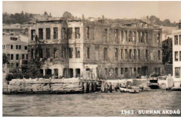
Resim.5.266. Esmâ Sultan Yalısı geçirdiği yangın sonrası cephe görünümü
