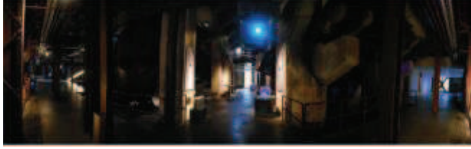
Resim.5.131. 1 numaralı makine dairesi, zemin kat yapay aydınlatma kullanımı, restorasyon sonrası (B. Kaşlı arşivi)
