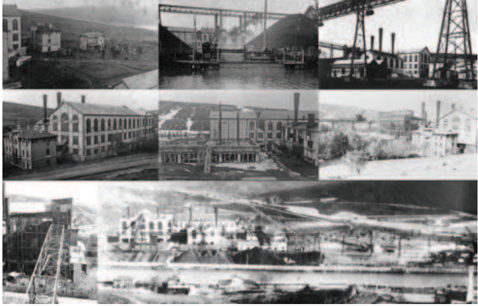
Resim.5.79. Silahtarğa Elektrik Santrali'nin restorasyon öncesi görünümü
