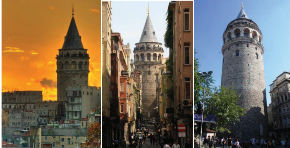
Resim.5.302. Son geçirdiği restorasyon sonrası Galata Kulesi'nin farklı açılardan cephe görünümü
