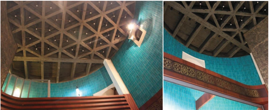
Resim.5.309. Galata Kulesi'nin giriş katında bulunan betonarme tavan
