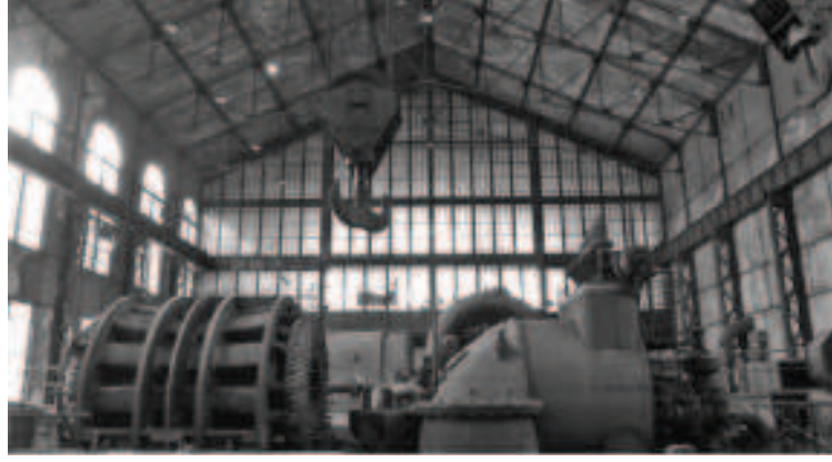
Resim.5.82. Restorasyon öncesi 1 numaralı makine dairesi ince dış kabuğun içeriden genel görünümü (Bilgi Üniversitesi Arşivi, Kaşlı, 2009)
