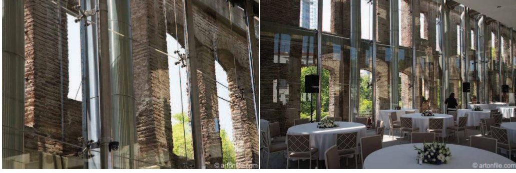
Resim.5.276. Restorasyon sonrası, 'The Marmara Esmâ Sultan'ın cam ve çelikten oluşan iç mekan ve detay görüntüleri
