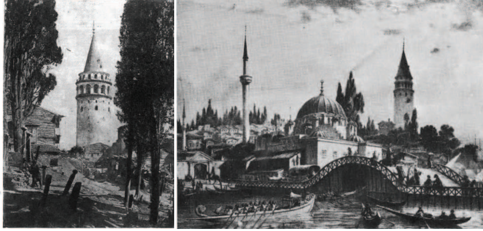
Resim.5.286. Galata Kulesi'nin (1832) II. Mahmut onarımından sonraki görünümü (Robertson'un fotoğrafı)-Turing klüb arşivi ve E. Flandin (1835-36) yıllarına ait taşbaskısı gravürde Unkapanı köprüsünden kulenin görünüşü (Arkitekt Mimarlık, Şehircilik, Belediyecilik ve Turizm Dergisi, 1964)
