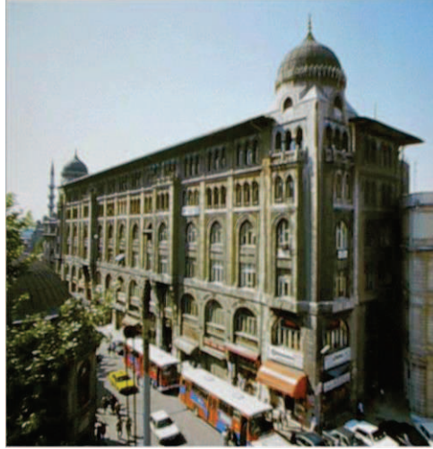
Resim.5.2. IV. Vakıf Hanı'nın uzun cephesindeki kuleler arasındaki saçakların ve cephenin görünümü
