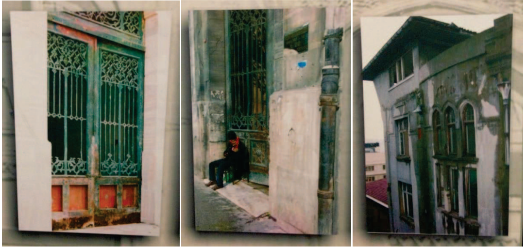
Resim.5.24. Restorasyon öncesi giriş ve deniz cephesinin görünümü
