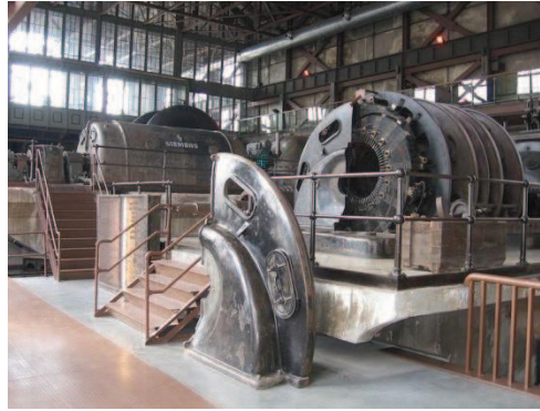
Resim.5.125. Türbin merkezindeki merdivenler
