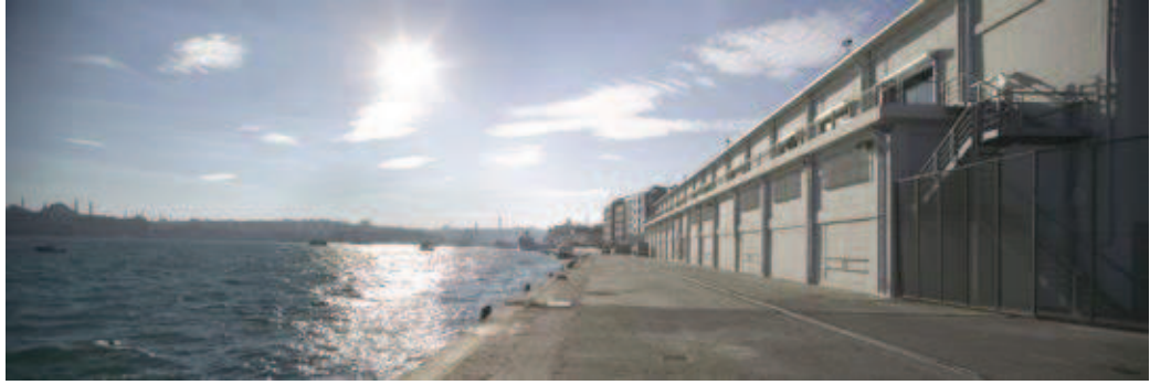
Resim.5.245. İstanbul Modern Sanat Müzesi cephe görünümü
