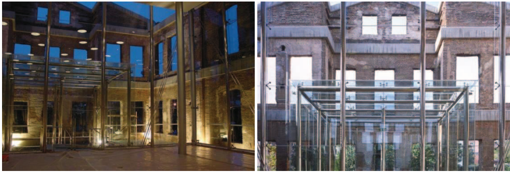
Resim.5.273. Restorasyon sonrası, 'The Marmara Esma Sultan' iç mekan görünümleri
