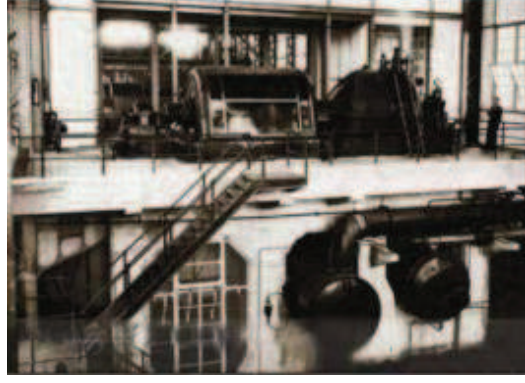
Resim.5.71. 2 numaralı makine dairesi içinde yer alan türbin-jeneratör grubu platformunun görünümü
