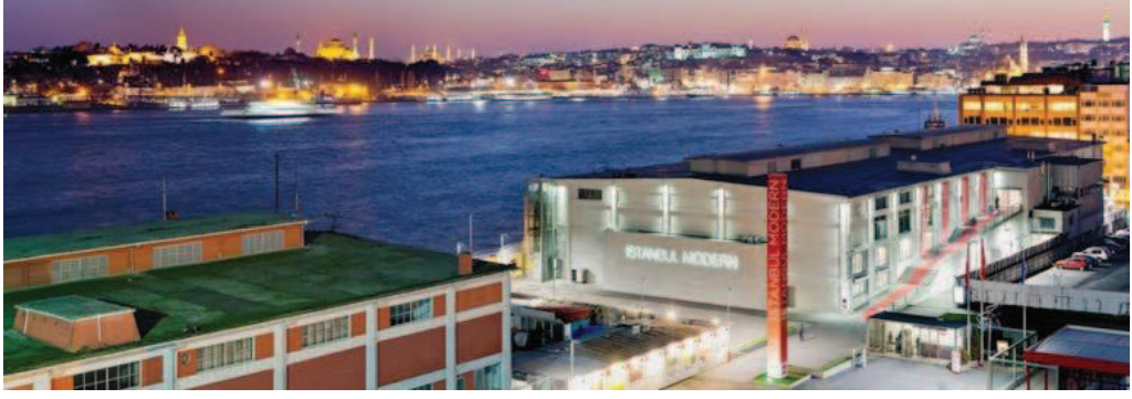
Resim.5.244. İstanbul Modern Sanat Müzesi cephe görünümü
