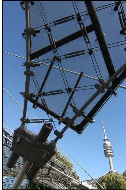
Şekil.63. Münih Olimpiyat Stadyumu Çelik Halat Birleşim Detayı
