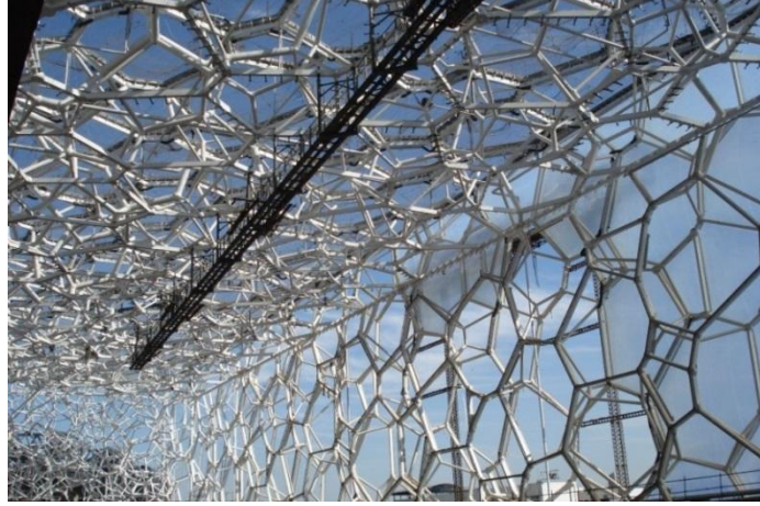
Şekil.23. Geometrik Köpük Formun Etfе ile Kaplanması
