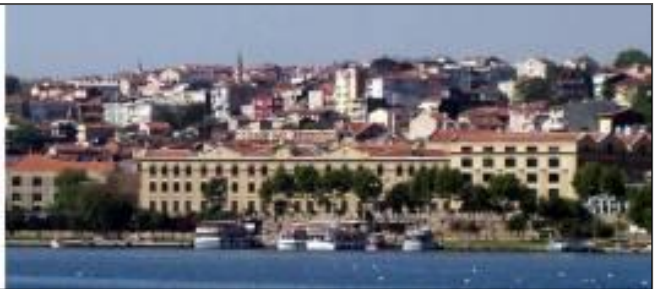
Resim.24. Cibali Tütün ve Sigara Fabrikası Dönüşüm Sonrası Görünümü, Kadir Has Üniversitesi
