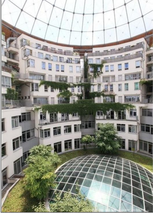
Resim.8. Viyana C Gazometresi İç Mekan ( http://www.wiener-gasometer.at/en/gasometer/c , Eylül 2012)
