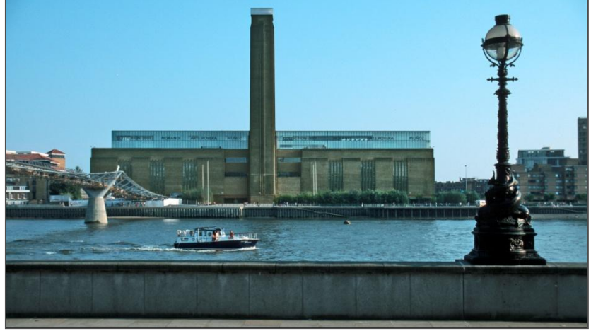
Resim.18. Tate Elektrik Santrali Dönüşüm Sonrası Görünüşü ( http://commons.wikimedia.org/wiki/File:Tate_modern_london_2001_02.jpg )
