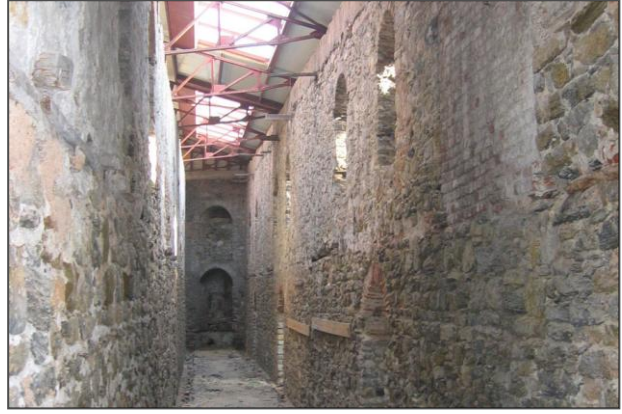
Resim.64. Kasımpaşa Tuz Ambarı Dönüşüm Öncesi İç Mekan
