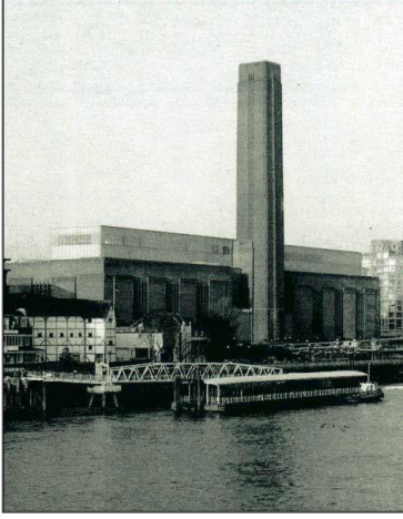
Resim.17. Tate Elektrik Santrali Dönüşüm Öncesi Görünüşü (Özer, 2000)
