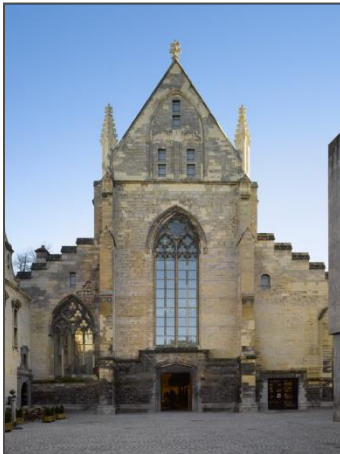
Resim.14. Dominik Kilisesinin Görünüşü
