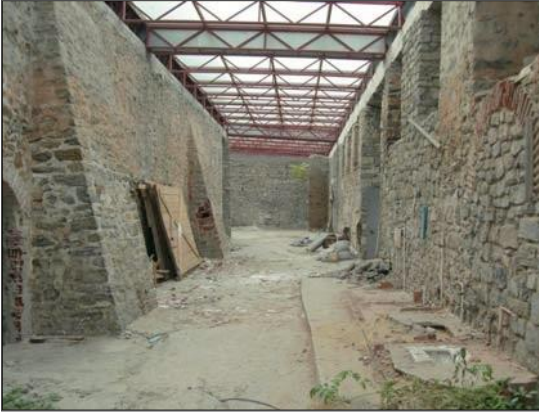
Resim.63. Kasımpaşa Tuz Ambarı Dönüşüm Öncesi İç Mekan (Pekol, B., 2010)
