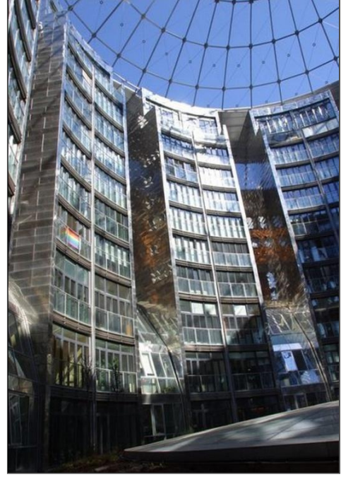
Resim.9. Viyana A Gazometresi İç Mekan ( http://www.wiener-gasometer.at/en/gasometer/a , Eylül 2012)
