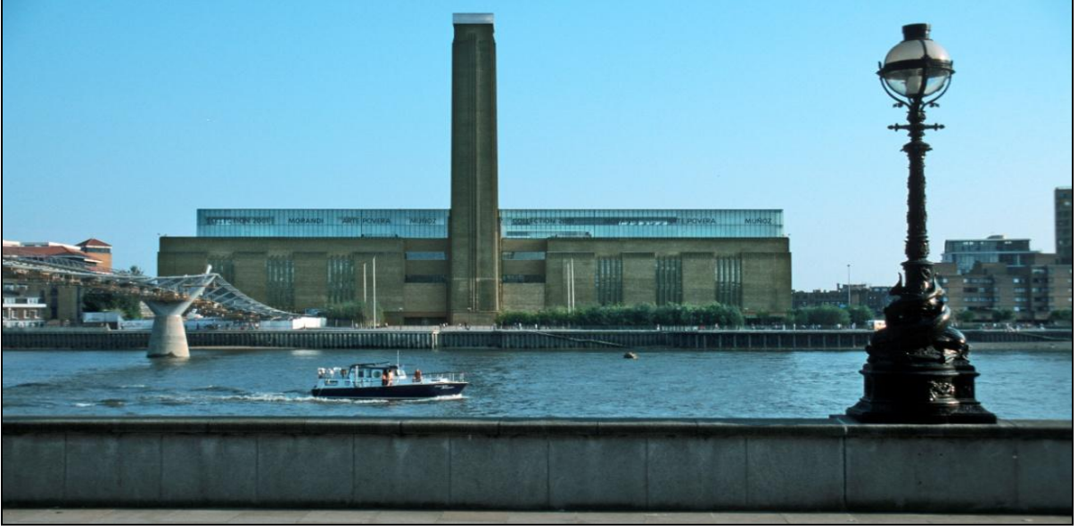
Resim.2. Tate Elektrik Santrali'nin Dönüşüm Sonrası Görünümü
