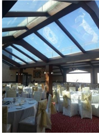
Fotoğraf.61. IV. Vakıfhan Arka Cephe Çatı Katı (Hakyemez Arşivi, 2014)
