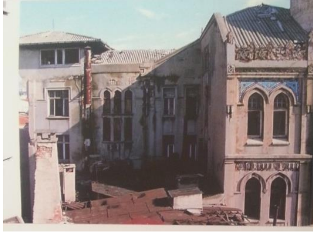
Fotoğraf.75. IV.Vakıfhan Restorasyon Öncesi Dış Cephe Durumu
