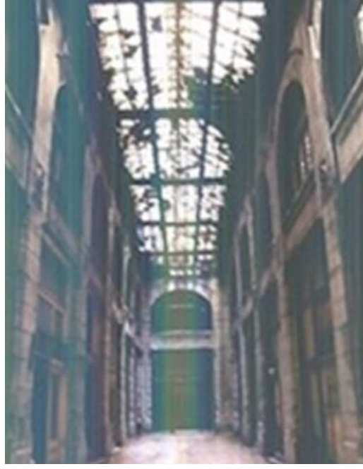
Fotoğraf.84. Çatı Örtüsünün Restorasyon Öncesi
