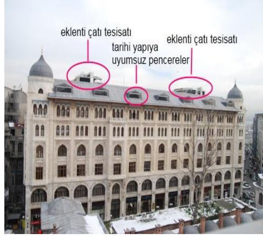
Şekil.29. IV. Vakıfhan Çatı Katı Penceresi
