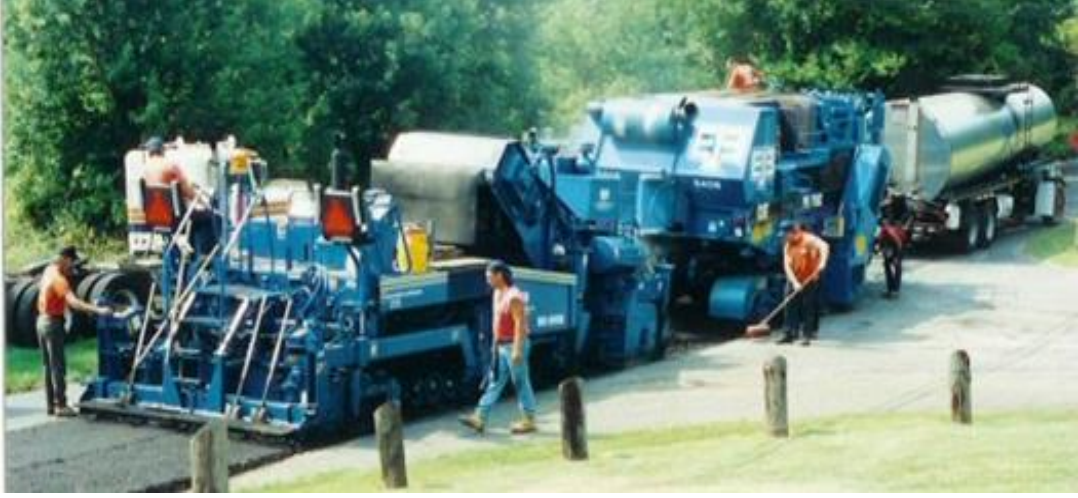
Resim 6.b Kazınılmış Asfaltların Değerlendirilmesi
