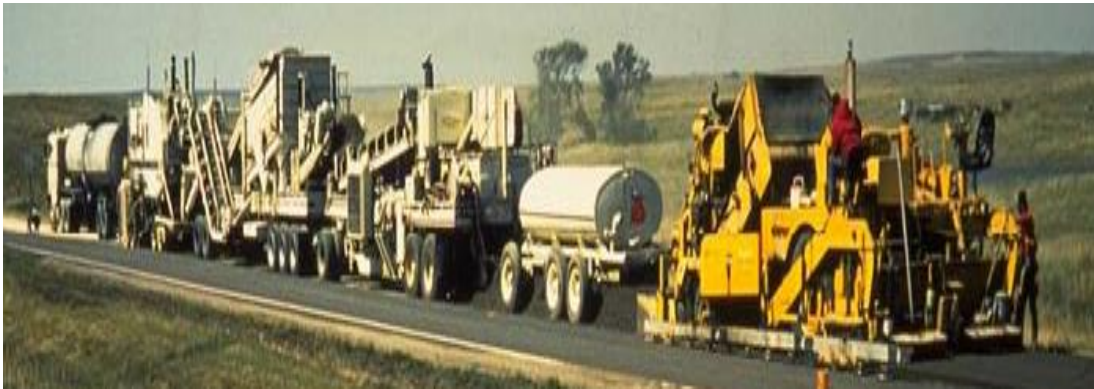
Resim 6.a Kazınılmış Asfaltların Değerlendirilmesi
