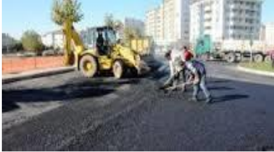
Resim 5. Kazınılan Asfaltın Tekrar Kullanımı
