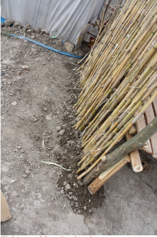
(Ek 3.4 – e): ıslak zemin çökme detayı
