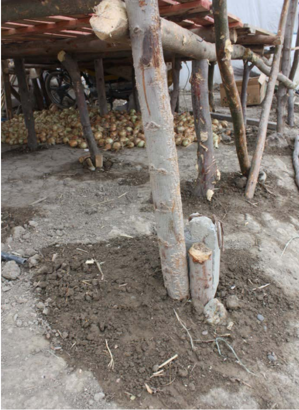
(Ek 3.4. – e): ıslak zemin çökme detayı
