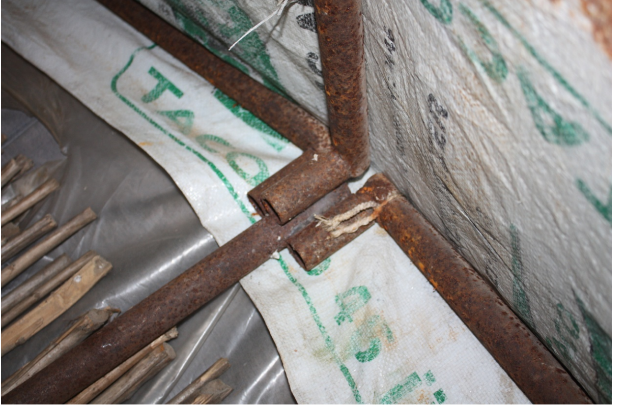
(Ek 3.4 – 1): L boru erkek – diři geme detayı
