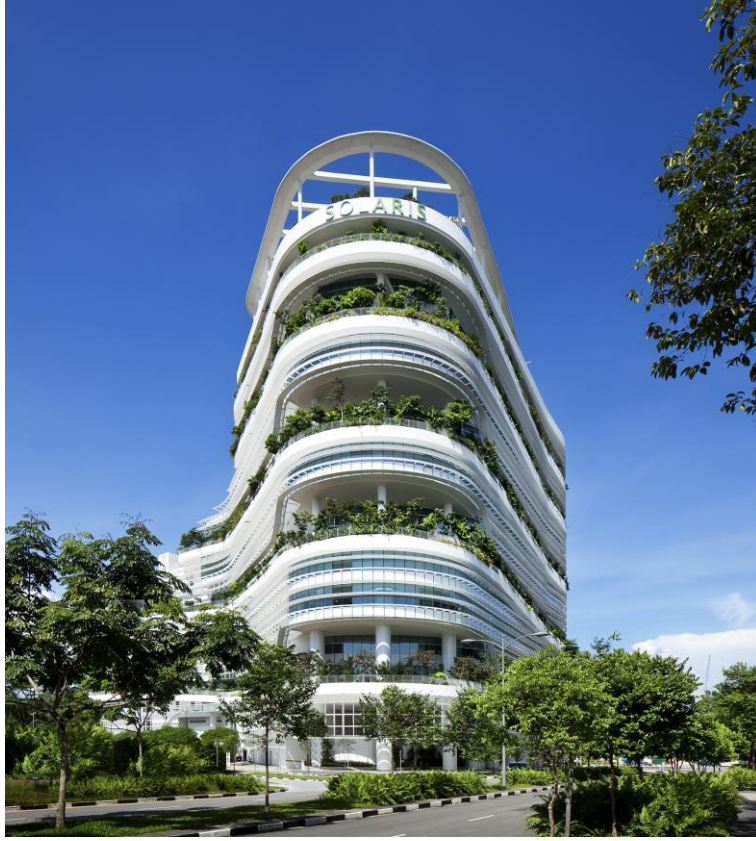
Şekil 29. Solaris Tower Projesi
