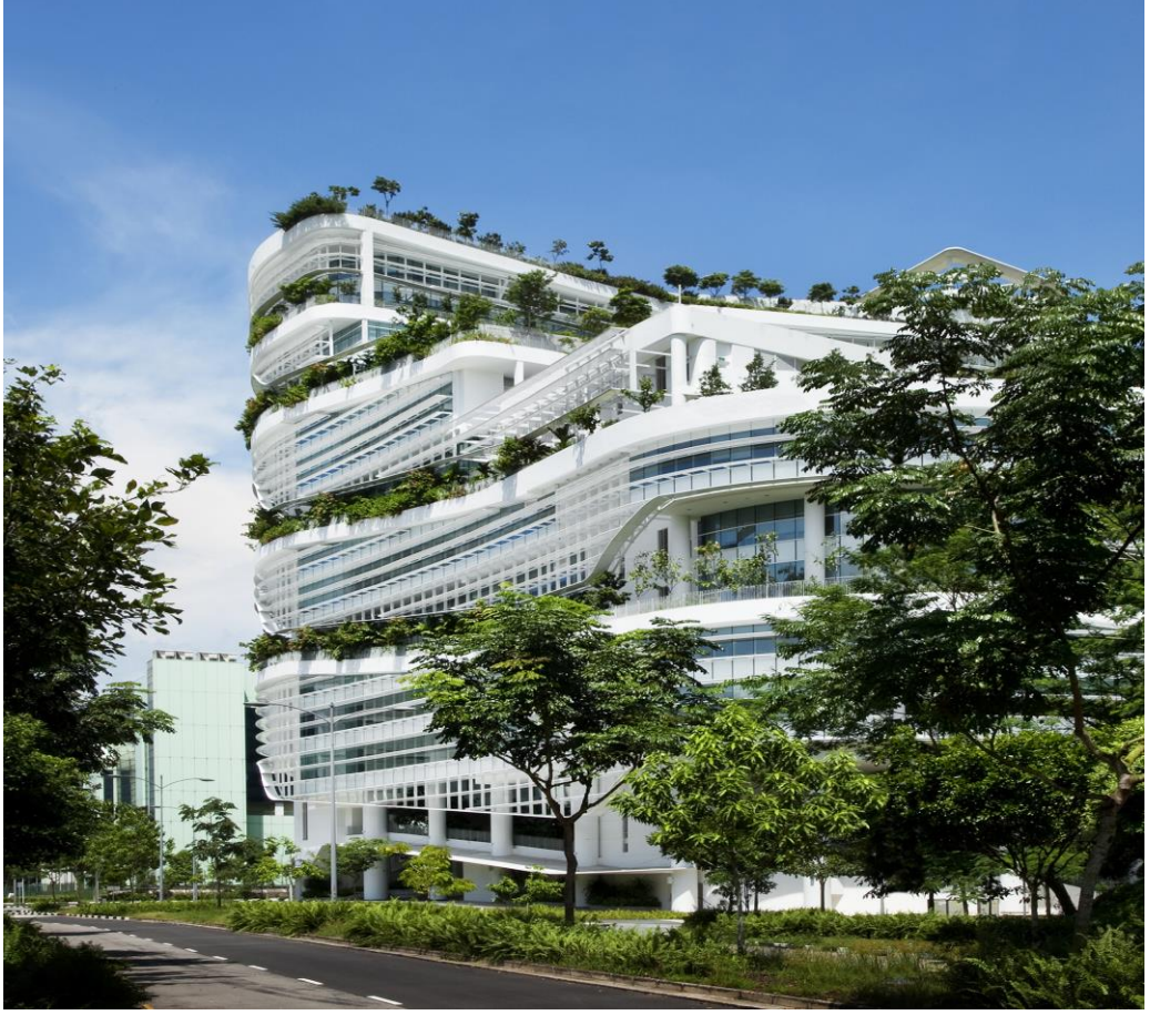
Şekil 33. Solaris Tower Projesi
