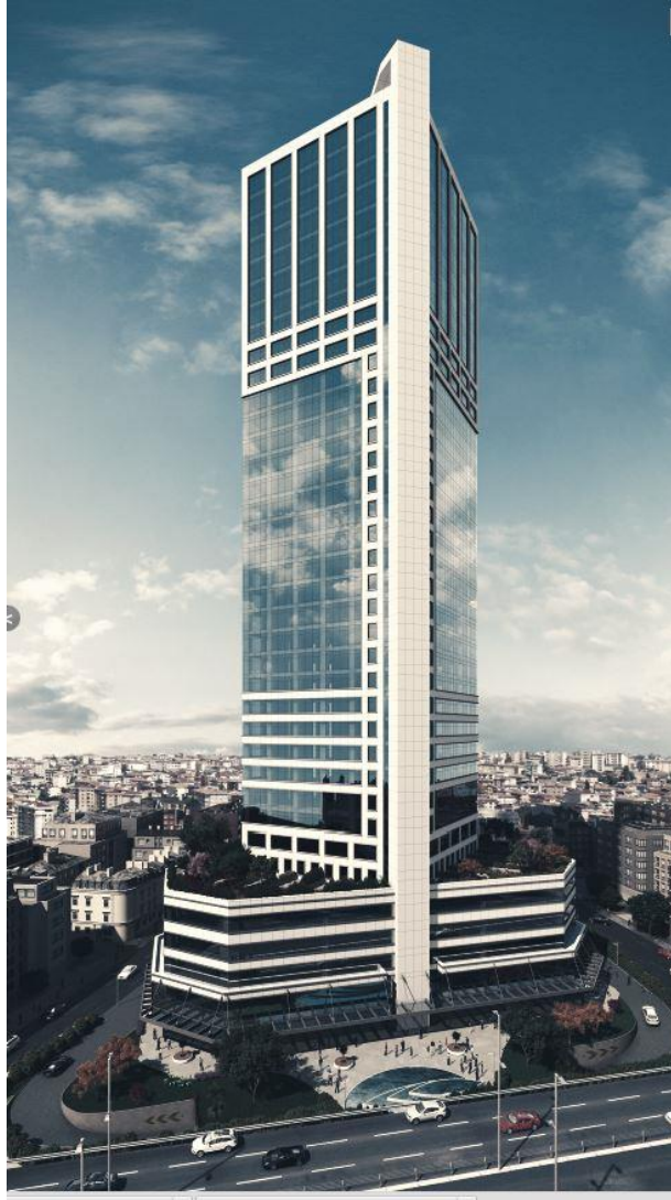
Şekil 51. Nurol Tower Binası
