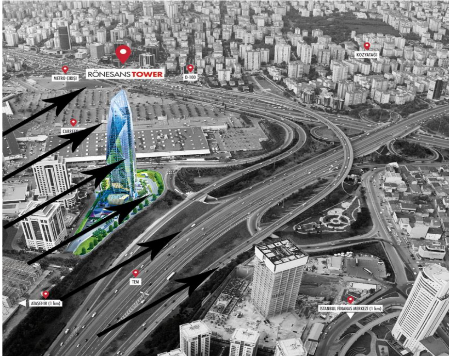
Şekil 85. Rönesans Tower Binası Ve Hakim Rüzgar Hareketi
