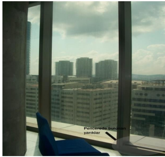
Şekil 27. Cam Doğrama Birleşiminde Açılan yarıklar
