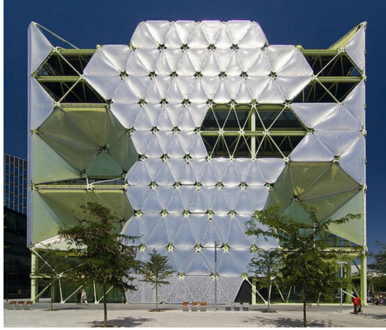
Şekil.76. Media-TIC Binası - İspanya - Barselona [75]
