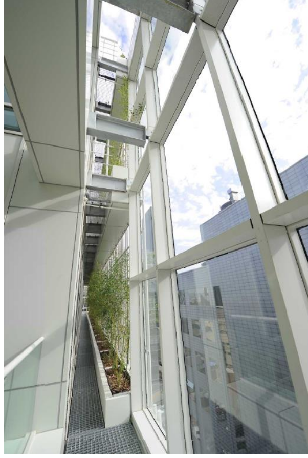
Şekil.87. Levent Ofis Binası – Çok Katlı ÇCKC – Kedi Yolu [76]
