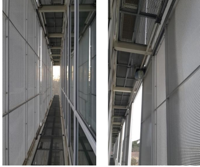
Şekil.131.132. İTÜ Merkezi Derslik Binası Perspektif - Çok Katlı - Panjurlu ÇCKC [89]
