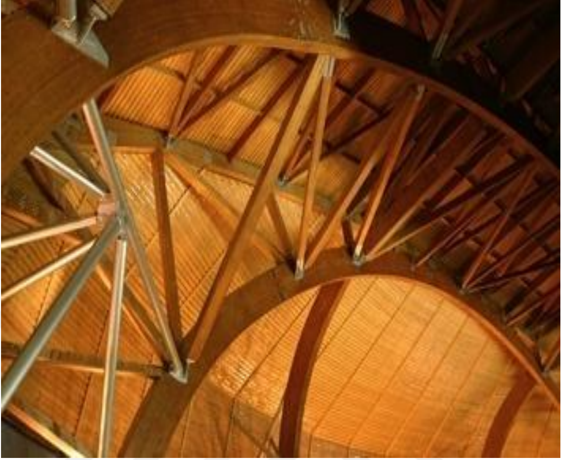
Fotoğraf.51. Eğrisel Kiriş Bağlantı Detayı (URL.42.)
