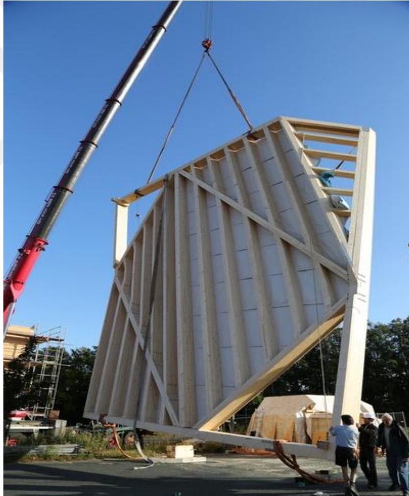
Fotoğraf.42. Karkas Sistem Montajı (URL.33.)
