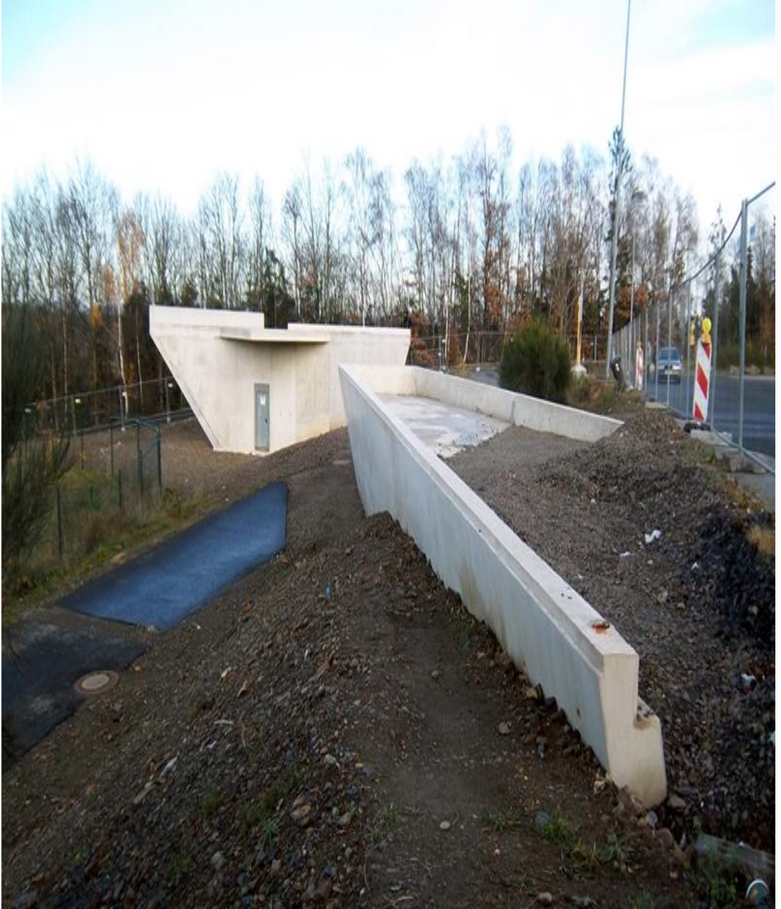
Fotoğraf.40. Zemin Betonu (URL.31.)
