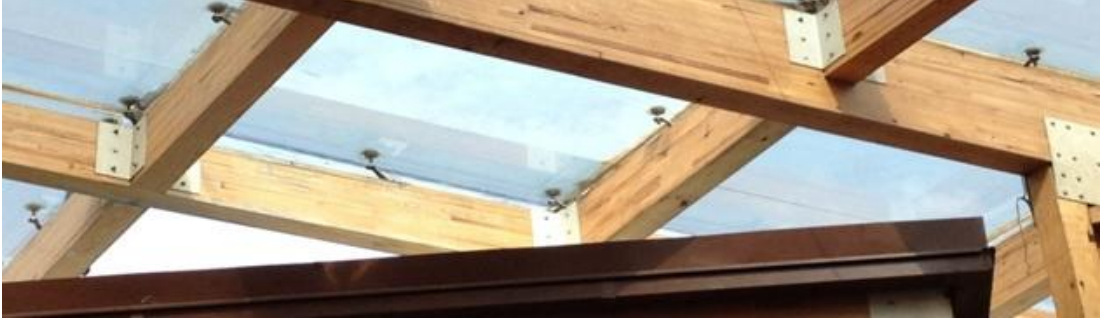
Fotoğraf.10. Lamine Cam ve Bağlantı Elemanları (AK Arşivi, 2015)
