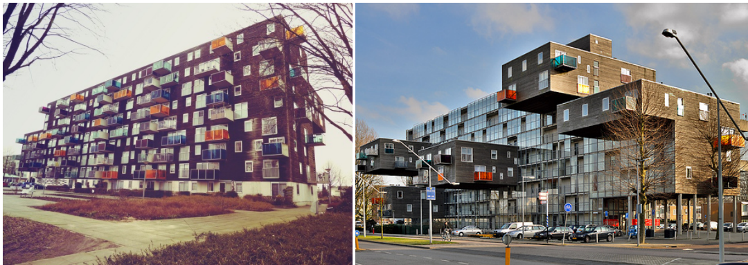
Şekil 4.26 Wozoco Binası’nın Cephelerinden Görünümler
