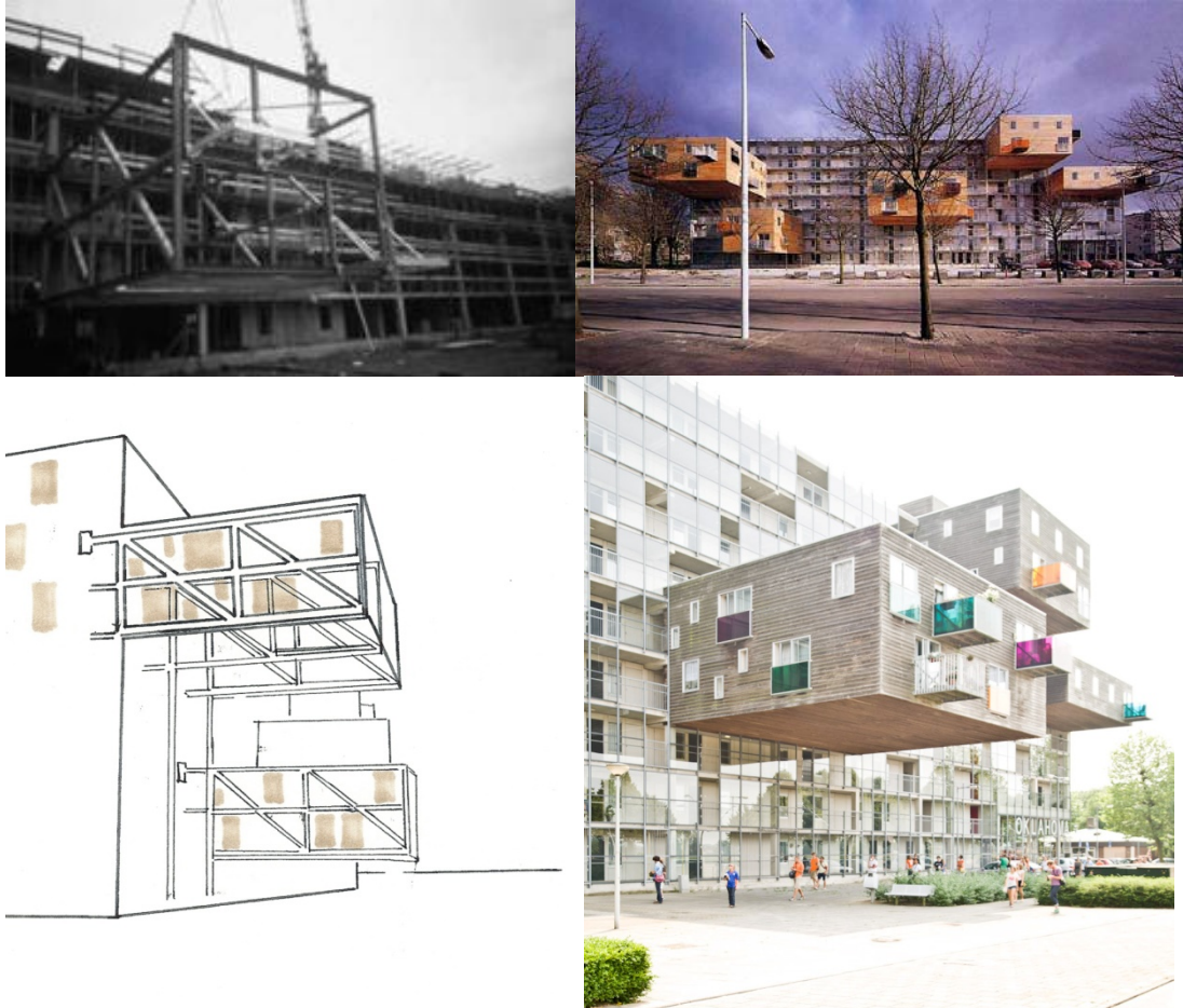
Şekil 4.28 Wozoco'daki eklenen birimlerin tasarım, montaj ve güncel görüntüleri
