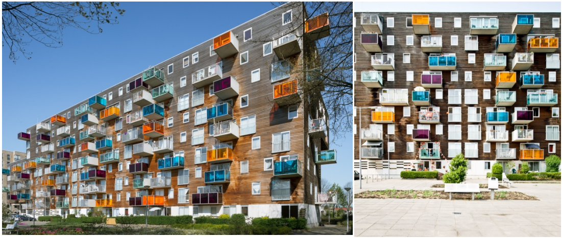
Şekil 4.29 - 4.30 Wozoco'nun Cephesindeki Çeşitlilikten Görünümler
