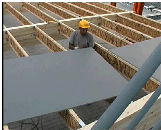
Şekil 4.83 Prefabrike yapım elemanları ile yalın inşaat prensiplerinin uygulanması
