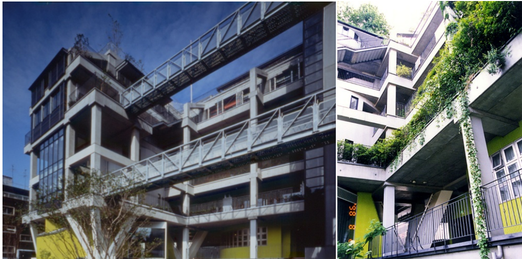
Şekil 4.14 Yapı İskeletini oluşturan dökme beton kolon ve kirişler
