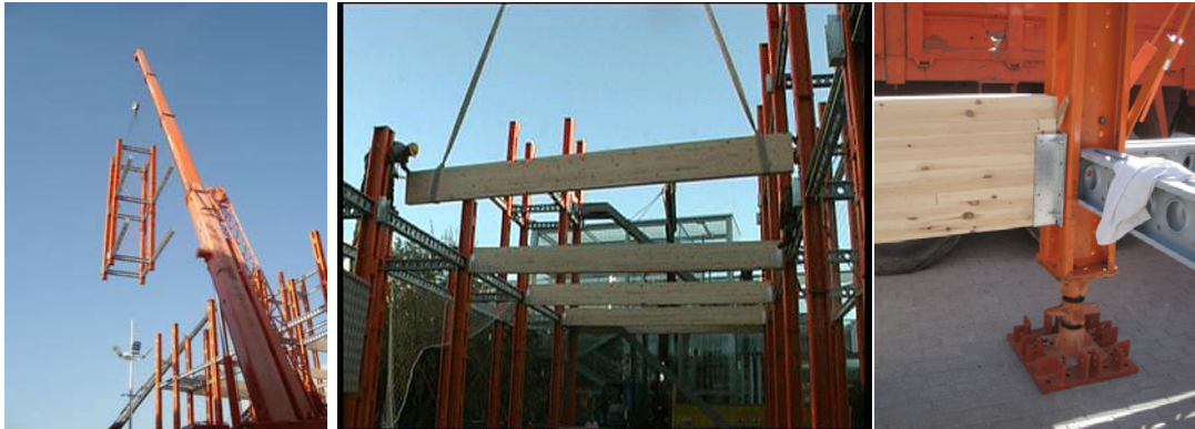
Şekil 4.76 - 4.77 - 4.78 Modüler bileşenlerin kolay ve hızlı montaj şekilleri
