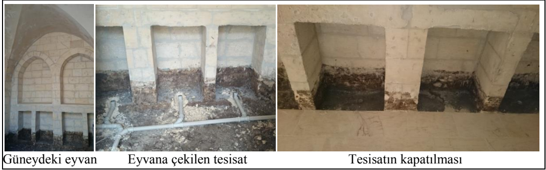
Şekil.104. Güneydeki eyvanın dıştan sızan suya karşı çekilen tesisat (Ocak, 2015)
