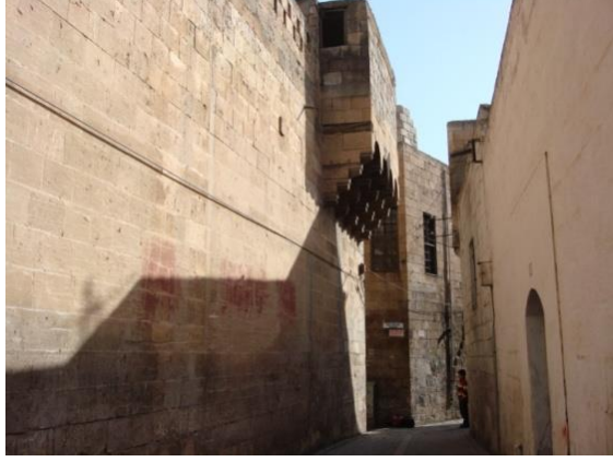
Şekil.21. Taş duvarlar ve sokaktan görünüm (Tevfik Saraç evi, 2005)
