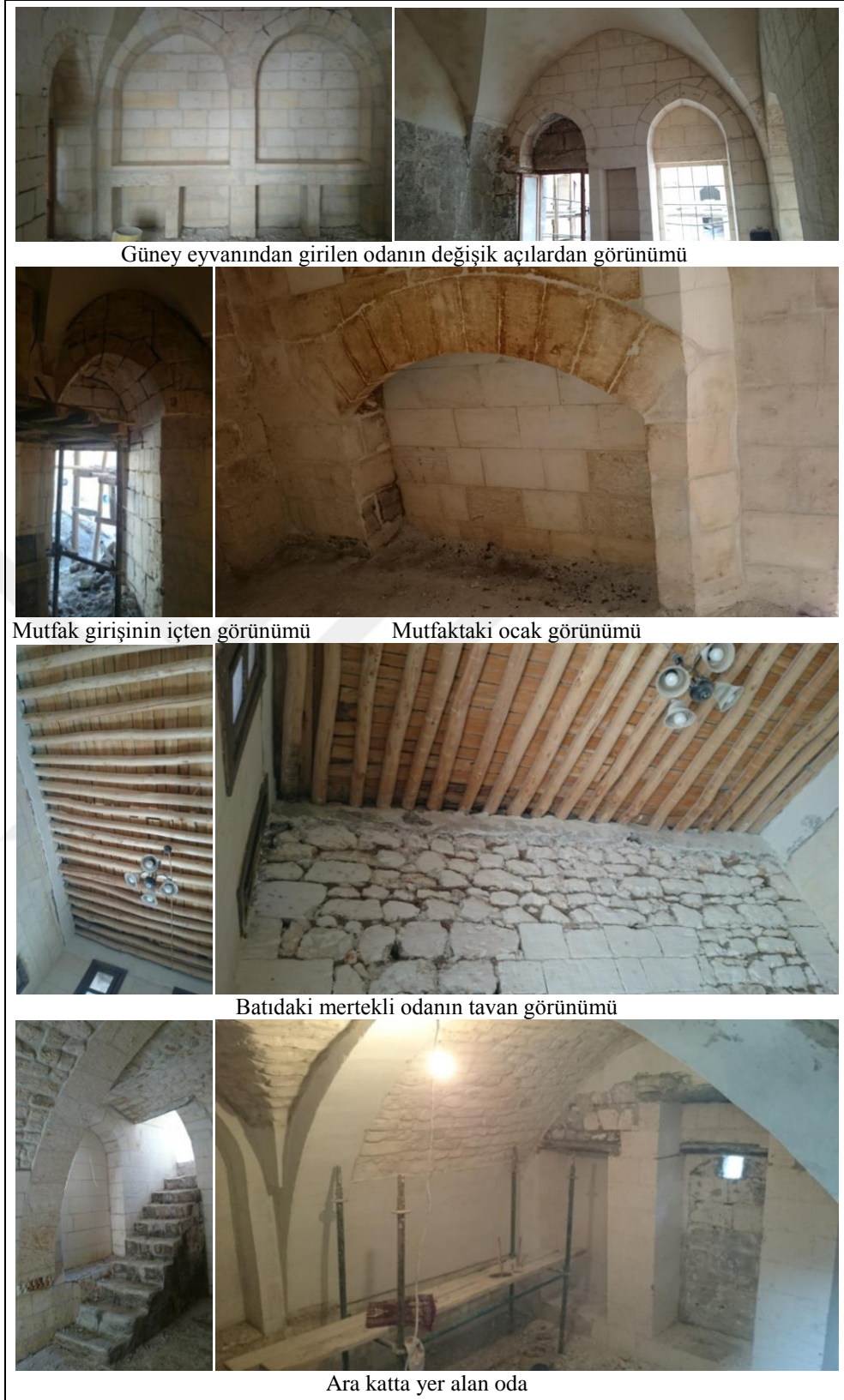
Şekil.102. Birinci kattaki restorasyon çalışmaları (2014)
