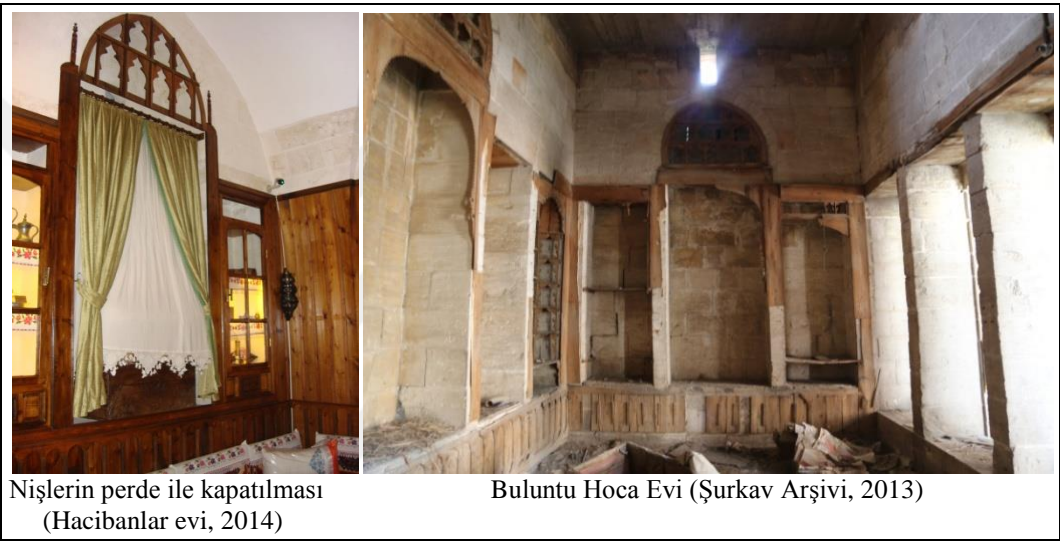
Şekil.30.b). Odadaki perde ile kapatılan camhane ve dolap nişlerinin görünümü
