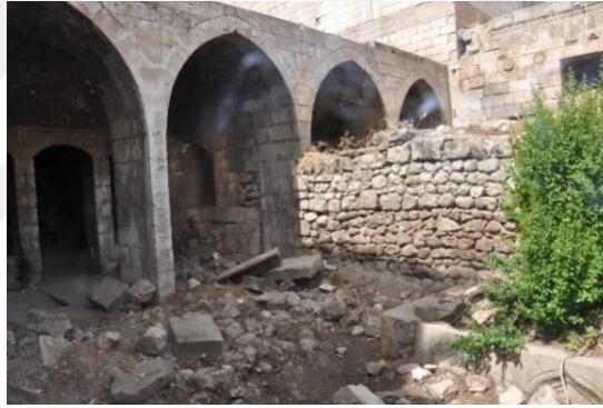
Şekil.16. Moloz ve kesme taş ile düz dam görünümü Abacı evi (Öcal A. Arşivi, 2010)
