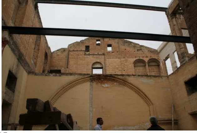
Şekil.25. Taşıyıcı demir profiller (M. Nedim Kürkçüoğlu Konağı, 2007)
