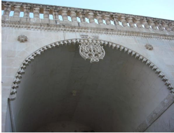
Şekil.12. Eyvan iç kenarlarındaki sakallı kemer görünümü (Hacibanlar evi-Mutfak Müzesi, 2014)
