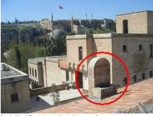
Şekil.45. Havalandırma bacası (Url.6)
