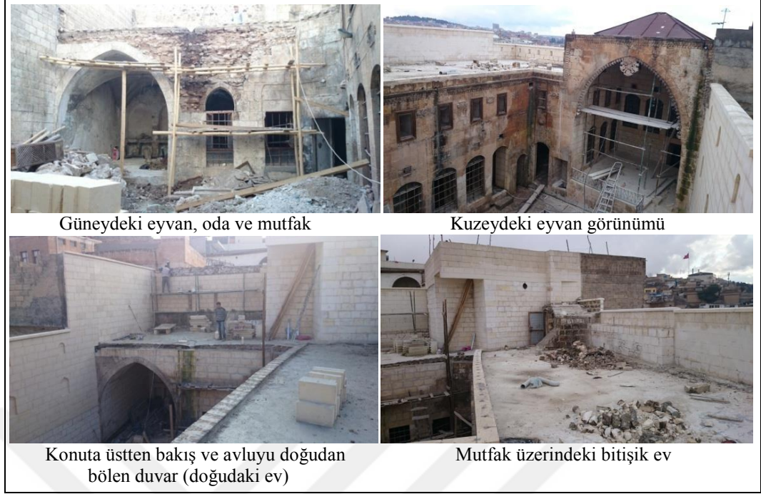
Şekil.103. Birinci kat ve damdaki restorasyon çalışmalarının dıştan görünümü (2014)
