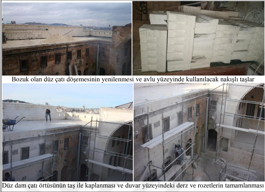
Şekil.107. Avlu dış yüzey ve düz dam çatı örtüsü çalışması, nakışlı taş görünümü (Restorasyon çalışmaları, Ocak, 2015)
