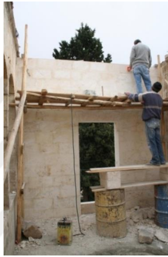
Şekil.20. Kesilmiş taşların örülmesi (M. N. Kürkçüoğlu Konağı restorasyon çalışması, 2007)
