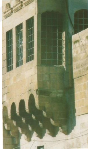
Şekil.18. Urfa evi-taş işlemeli çıkma görünümü (Oymak, 1998; 39)
