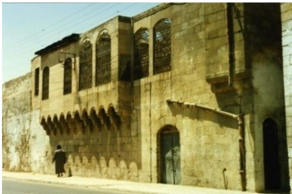
Şekil.13. Bir konutun sokaktan görünümü (Kürkçüoğlu, C. Arşivi)
