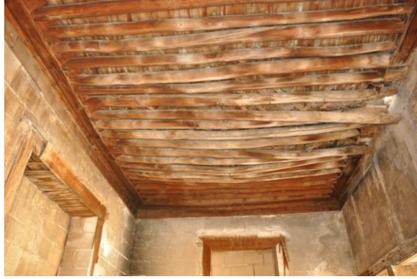
Şekil.23. Düz damlardaki, ahşap mertek görünümü (2007)
