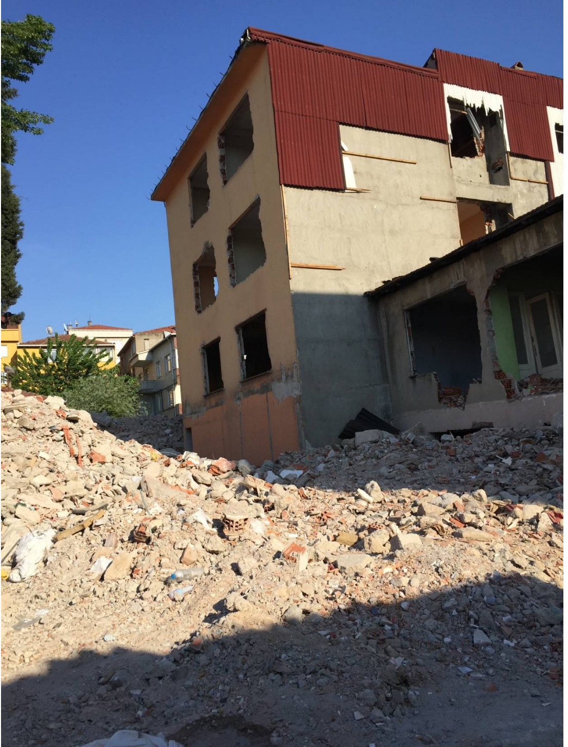
Şekil.21. Fikirtepe Terkedilmiş yapılar II
