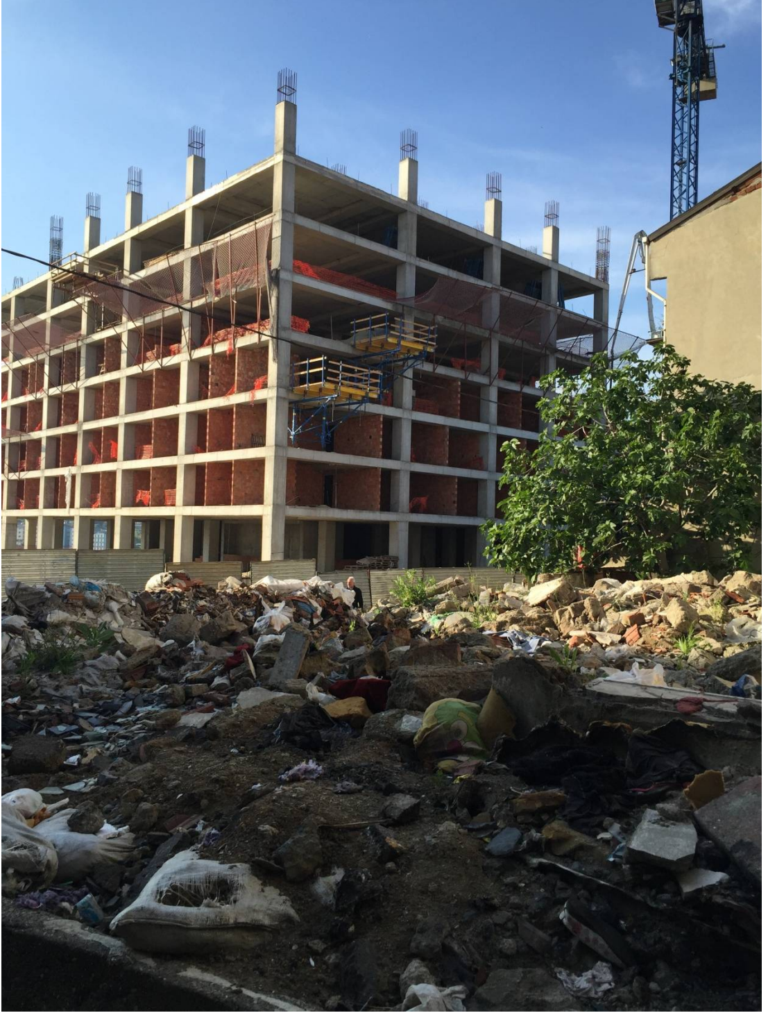
Şekil.24. Fikirtepe İnşaatına Başlanmış Yapılar I
