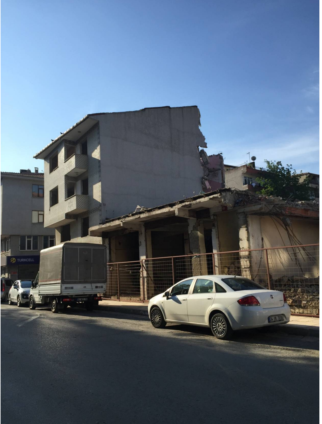
Şekil.23. Fikirtepe Terkedilmiş yapılar IV
