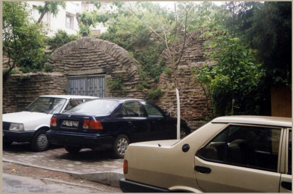
Şekil 4.45.A. Kambur Mustafa Paşa Camii Altındaki Sarnıç 1997 yılında Cephe Görünümü (Url-49)
