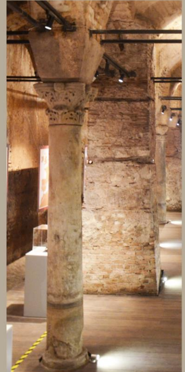
Şekil 3.14.F. Nakkaş (Nakilbent Sokağı) Sarnıcı Sütun Görünümü (Yıldırım Arşivi)
