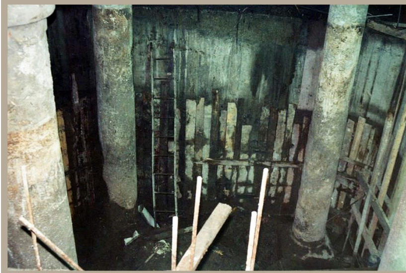
Şekil 4.21.A. Restorasyon Süreci-Beton Dökme Çalışmaları (Url 40)
