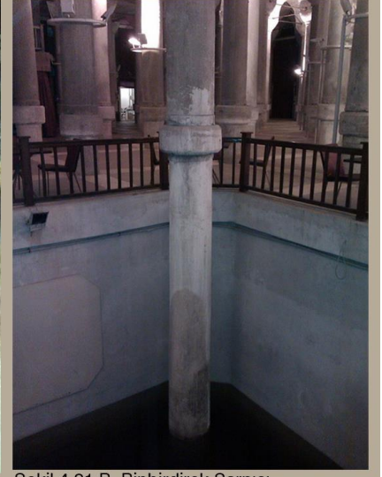
Şekil 4.21.B. Binbirdirek Sarnıcı Restorasyondan Sonraki Görünüm (Yıldırım Arşivi)
