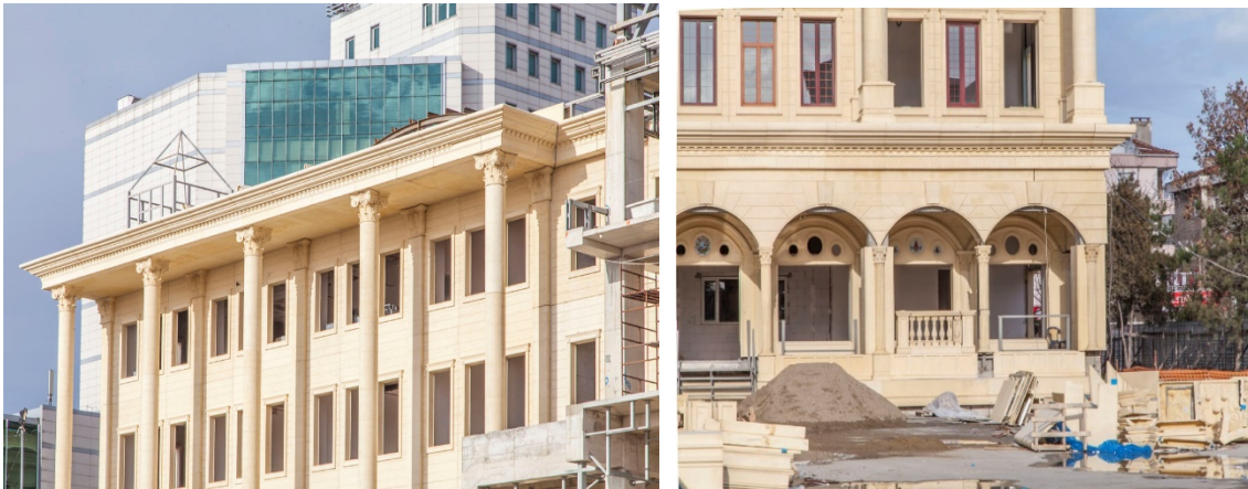
Şekil 2.79. Büyükçekmece Belediye Binası Kolon, Kemer ve Silme Detayı - İstanbul, Türkiye
