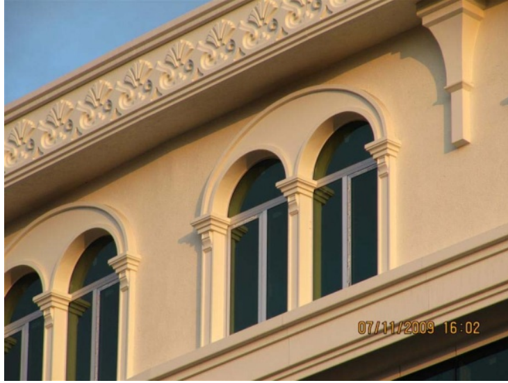
Şekil 2.60. Kat Ve Saçak Kuşakları Uygulaması ( http://alcastone.com.tr ,15.09.2015)
