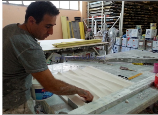
Şekil 2.5. Kalıp Yapım Aşaması (Yazar Arşivinden,2015)
