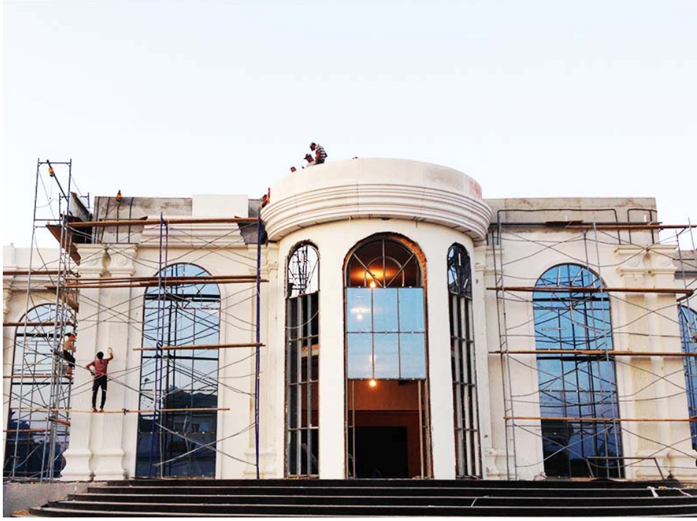
Şekil 2.52. Rusya Kültür Merkezi İnşaatı, Rusya
