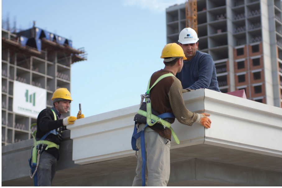
Şekil 2.9. Prekast Cephe Elemanlarında Montaj (Yazar Arşivinden, 2015)
