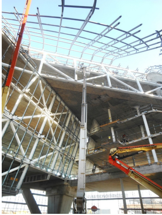
Şekil 2.33. Palazzo İtaly Çelik Sİsteme Prekast Malzemesinin Montajı ,2015
