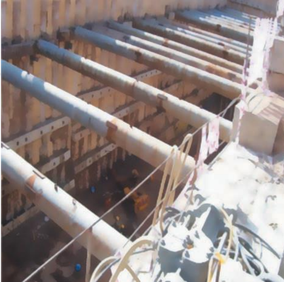
Şekil 3.6: Kazı Alanının Desteklenmesi
