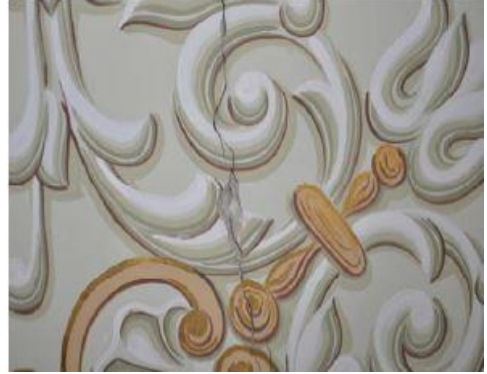
Fotoğraf 24a,b. Yıldız Sarayı Duvarda Görülen Sıva Çatlağı ve Bozulmalar
