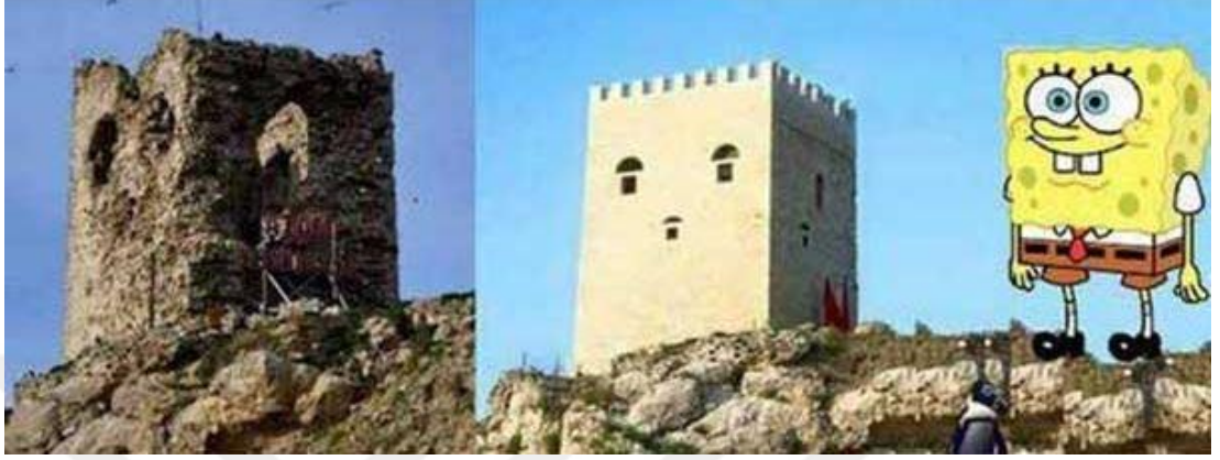
Fotoğraf 1a ve b. Şile Kalesi Restorasyon Çalışması
