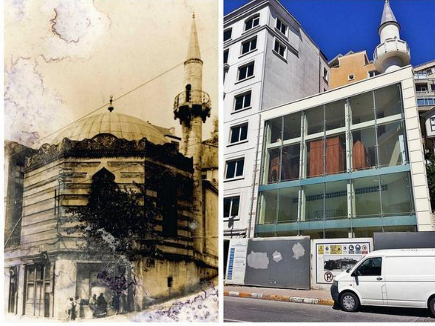
Fotoğraf 2. Süheyl Bey Camii Restorasyon Çalışması
