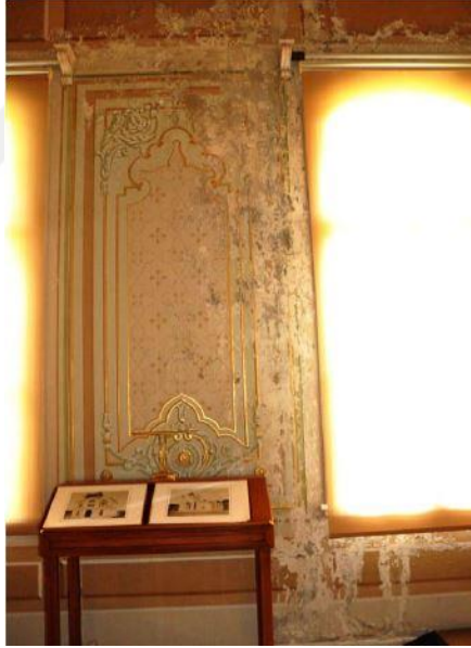
Fotoğraf 24a,b. Yıldız Sarayı Duvarda Görülen Sıva Çatlağı ve Bozulmalar
