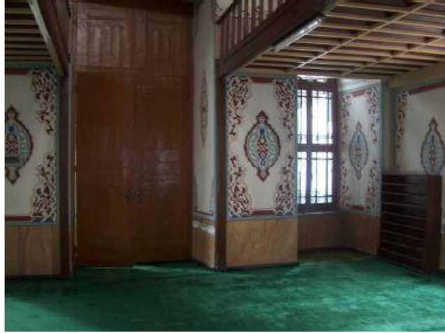
Fotoğraf 9. Hidayet Camii Onarım Öncesi Son Cemaatten Görünüm
