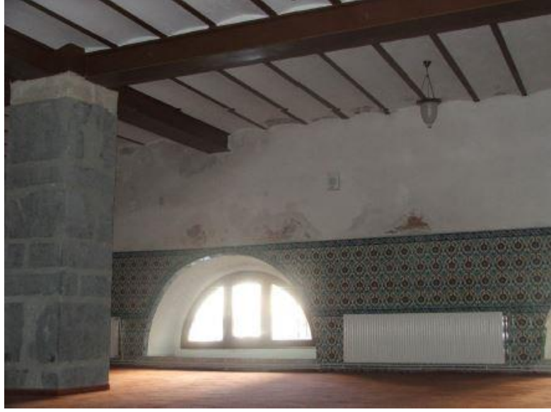
Fotoğraf 6. Hidayet Camii Restorasyon Sonrası Yağmur Tahribatı
