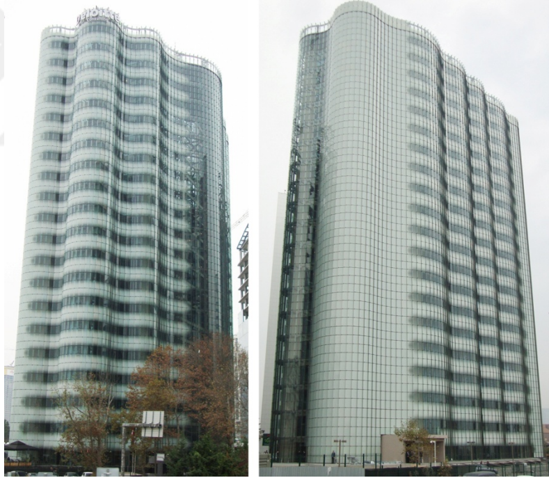
Şekil-69 Maslak No1 Ofis Binası Cephesi (Url-38)
