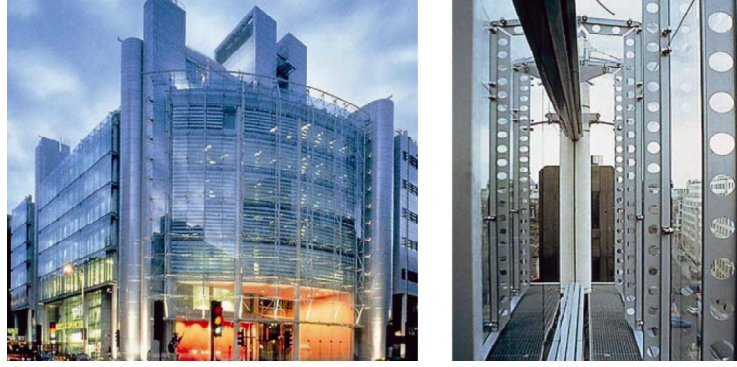
Şekil-50 Helicon Binasının Çift Kabuklu Cephe Görünüşü ve Detayı (1996, Londra, Mim. Shepherd Robson) (Jones, 1998)
