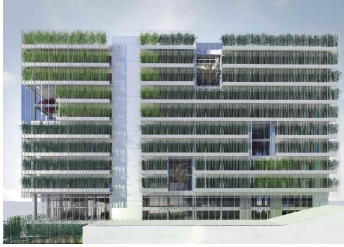
Şekil-82 Levent Ofis Binası Güney Cephe Fotoğrafi (Url-41)
