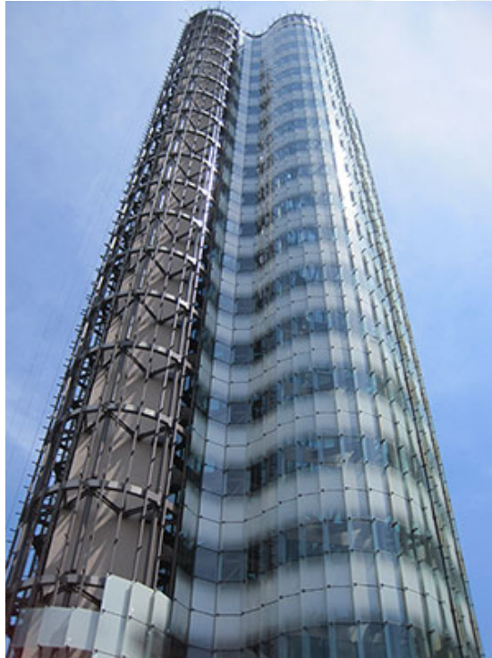
Şekil-66 Maslak No1 Ofis Binası Cehesi (Url-37)
