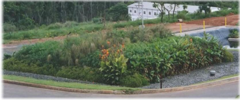
Şekil-29 Suyu Temizlemek İçin Tasarlanmış Sulak Alan (Oceans, 2007)
