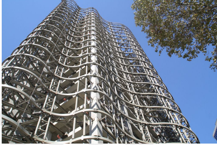
Şekil-65 Maslak No1 Ofis Binası Çelik Konstrüksiyonu (Url-37)
