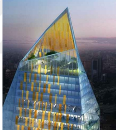
Şekil-94 Rönesans Tower Ofis Binası Kule Ucu (Url-45)
