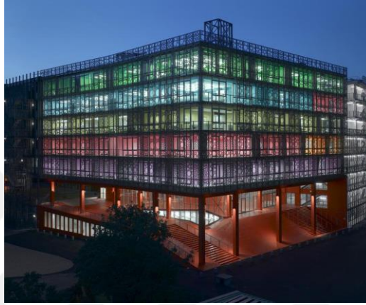
Şekil 29. Jussieu Üniversitesi Kampüsü 16 M Binası, Paris/Fransa (Aktaran: YEM, Kaynak: Luc Boegly)
