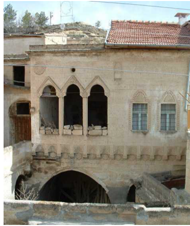
ŞEKİL 55. Yarı oyma-yarı yığma konutlarda alt kat ve üst kat eyvanına örnek (Yıldırım, 2004, sf.33)
