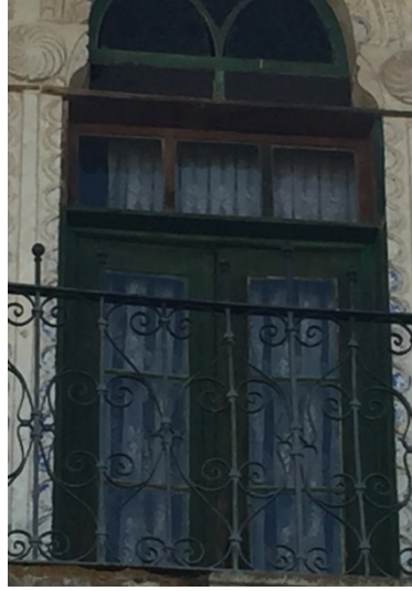
ŞEKİL 62. Ahşap ve demir malzemenin kullanım yerleri (Demirkol Arşivi, 2015)
