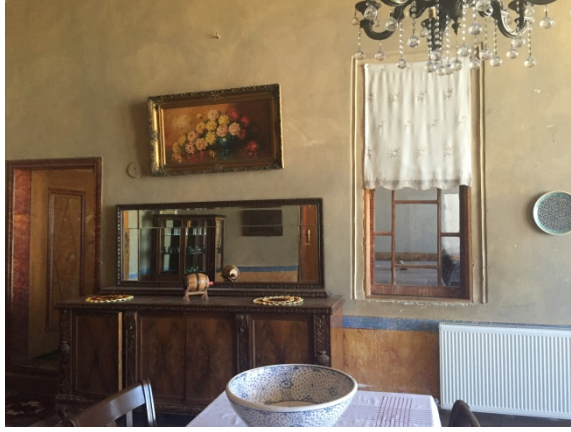
ŞEKİL 94. Konutlardaki ısıtma sistemleri (Demirkol Arşivi,2015)
