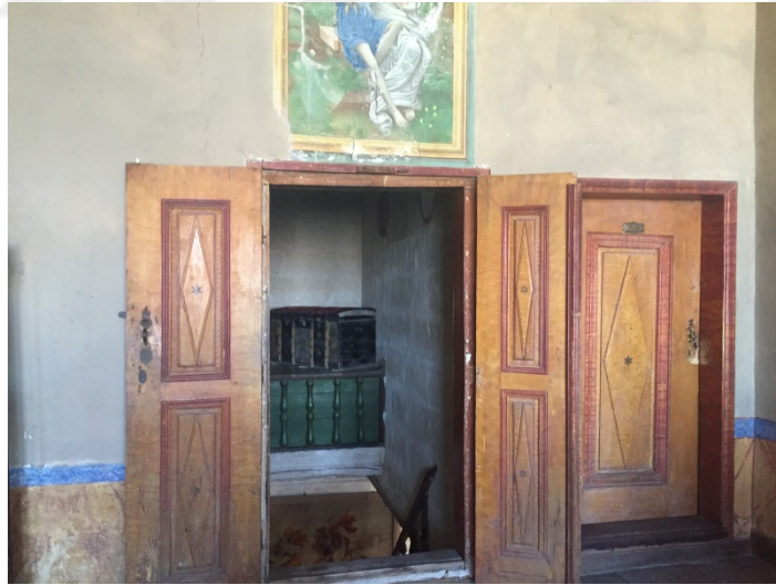
ŞEKİL 106. Old Greek House duvar restorasyon sonrası duvar
