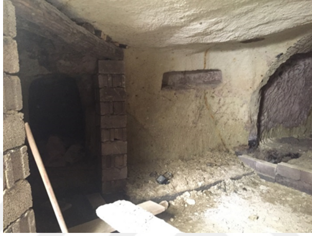
ŞEKİL 42. Jerveni Cave Hotel yeni mağara oda inşaat aşaması (Demirkol Arşivi, 2015)
