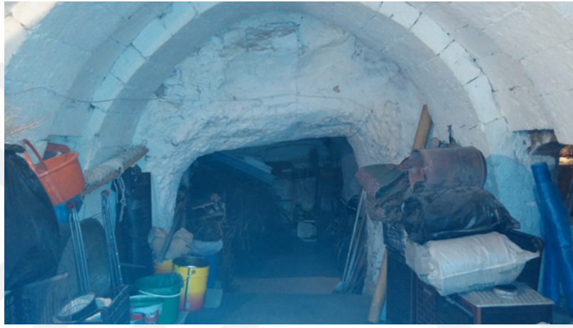
ŞEKİL 75. Hasan Biçer Evi restorasyon öncesi yaz mutfağı (Kabaltı Mimarlık Ltd. Şti. 2015)
