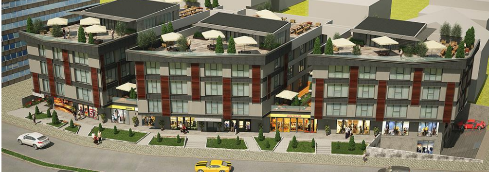
Şekil 77: İLY Terrace ön cephe görünüşü
