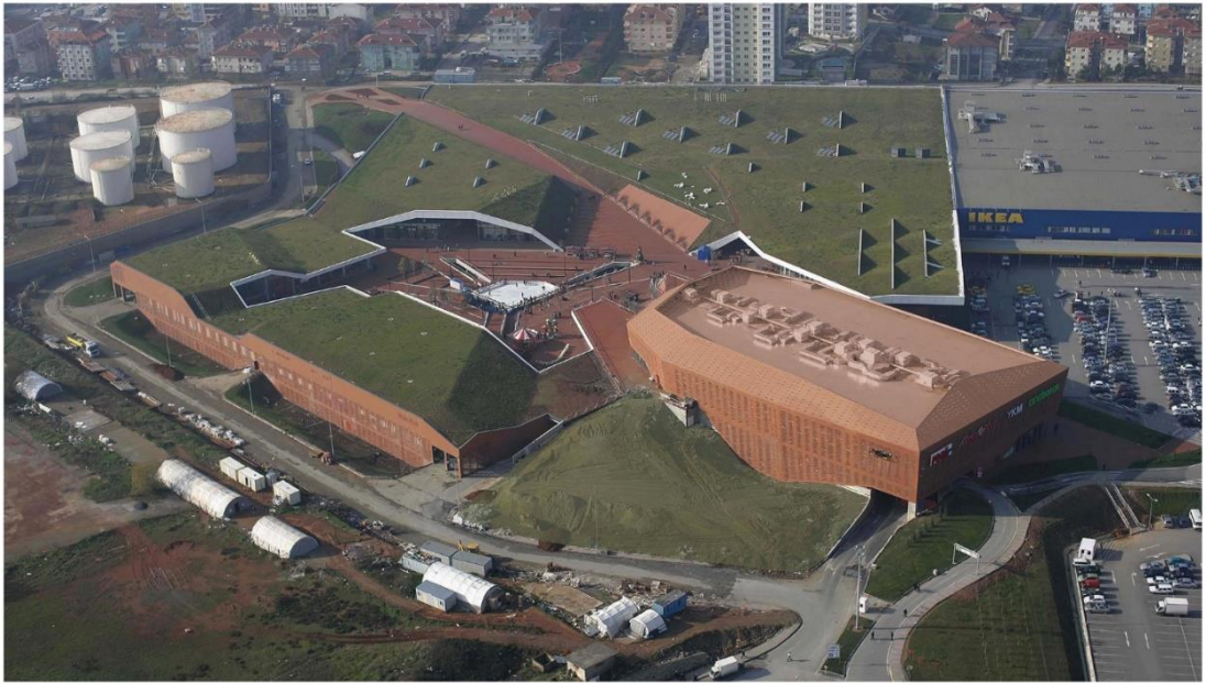
Şekil.12. Foa Architects, Meydan Alışveriş Merkezi, İstanbul[32]
