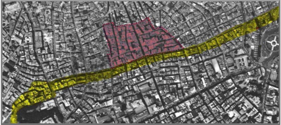
Şekil.7. Tarlabası Bulvarı'nın açılması için yıkılan binalar (Hava Fotoğrafı, 1982) [27]
