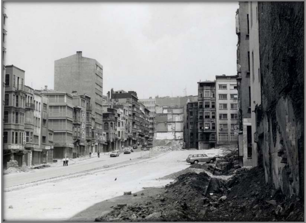
Şekil.8. yıkım çalışmaları sırasında Tarlabaşı bulvarı 1988 [30].
