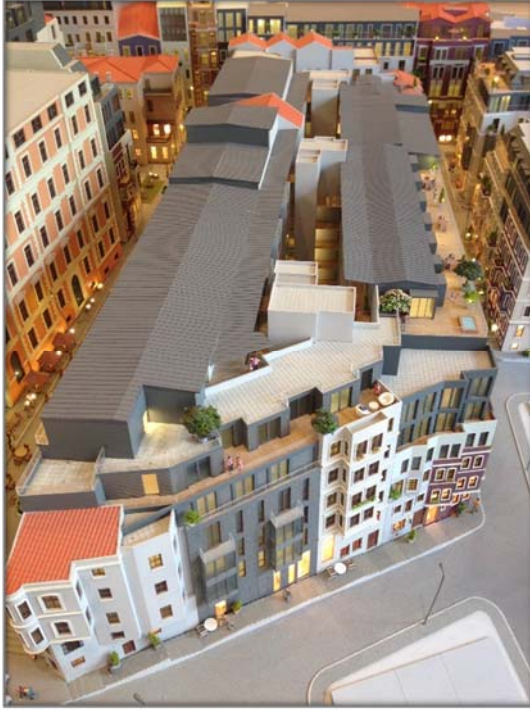
Şekil.81. 387 ada, Keresteci recep sokak, geri çekilerek eklenen katlar (S. Matin.2017)
