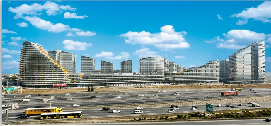
Şekil 4.38. Batışehir Cadde Üzerinden Görünüm [36]
