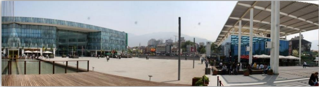
Şekil 2.3. Kent Meydanı Alışveriş Merkezi, Bursa [3]
