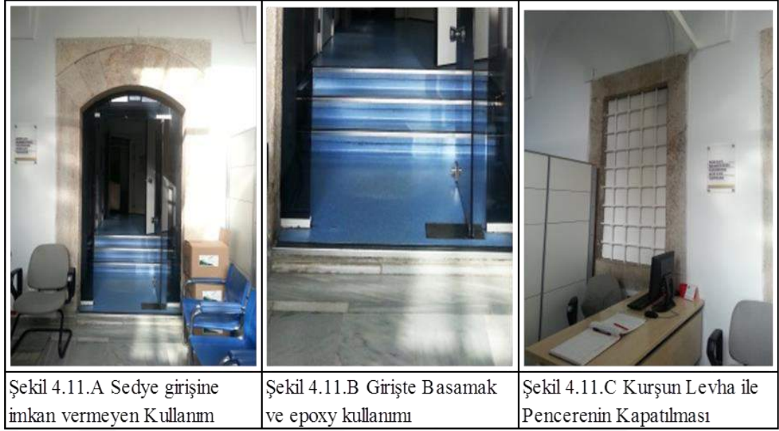
Şekil 4.11 Mihrimah Sultan Medresesi Dershanenin Kullanım Durumu (Yılmaz Arşivi)
