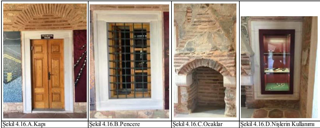
Şekil 4.16. Siyavuş Paşa Medresesi Mekansal Unsurlar (Yılmaz Arşivi)
