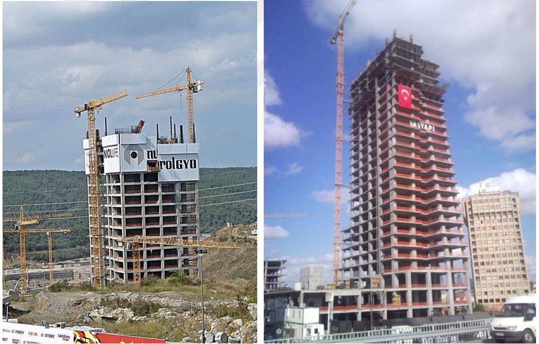
Şekil 39. Nurol Life Residence İnşaatı / Trump Tower Residence İnşaatı
