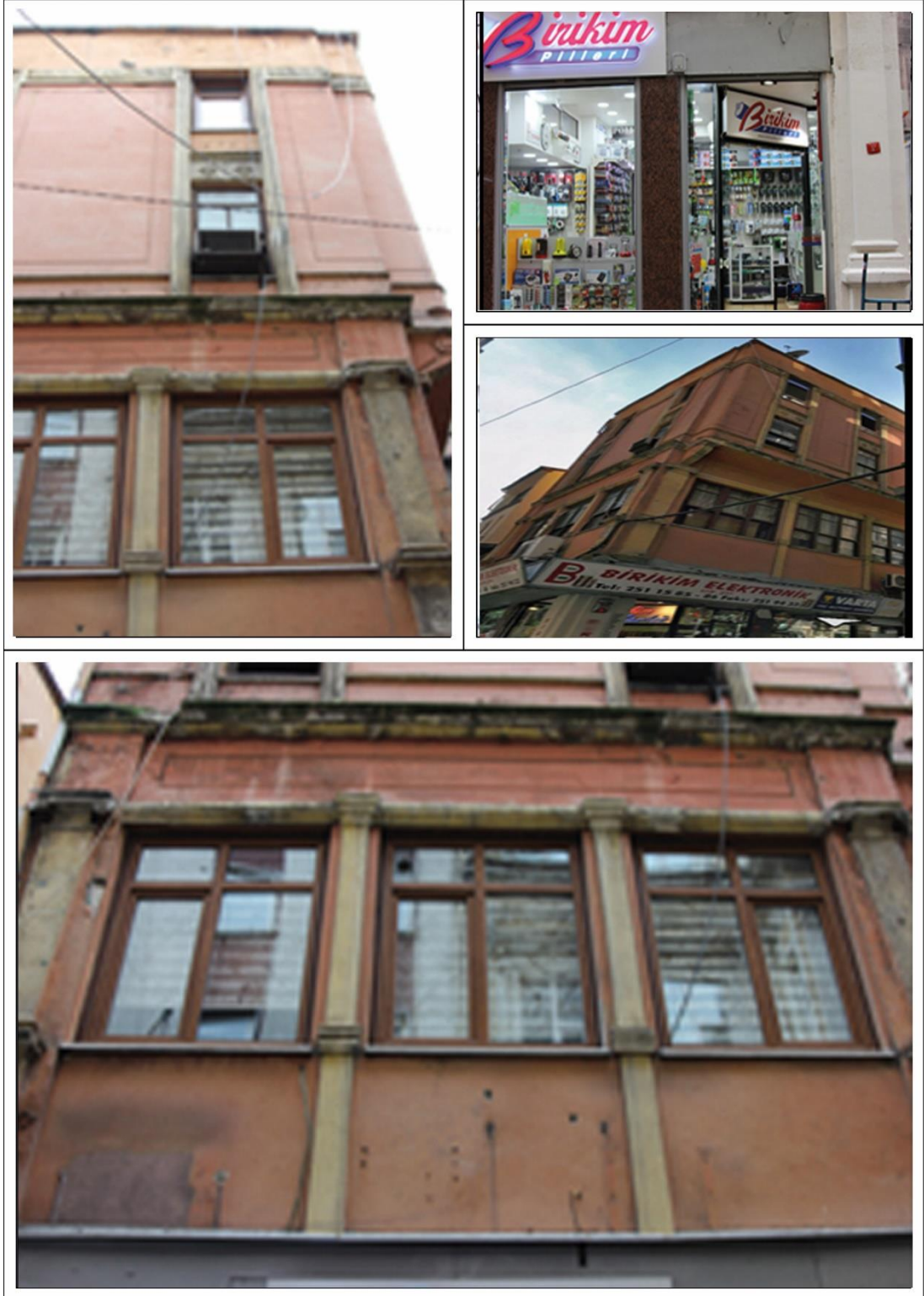
Resim 7: 1 No'lu Yapı / Detaylar / 2016
