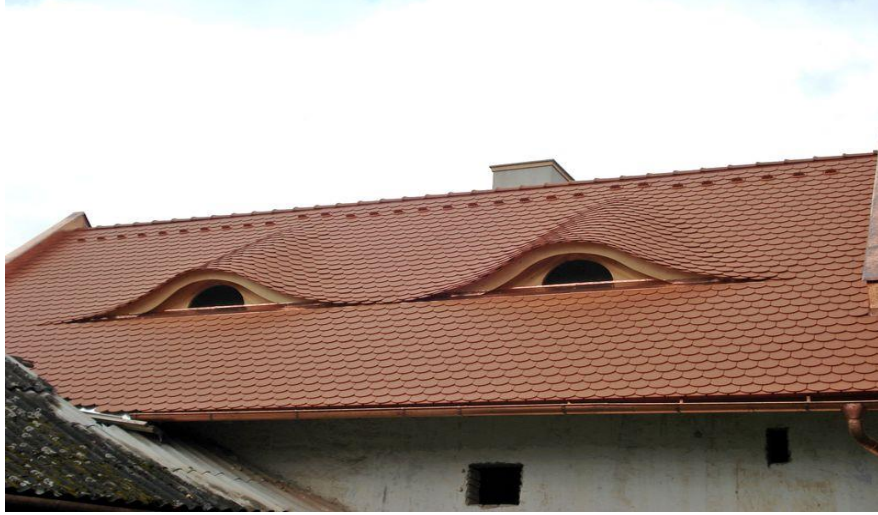
Şekil 23. Düz kunduz kuyruğu kiremit ile uygulanan yarasa pencere
