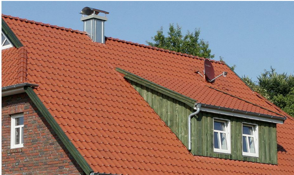
Şekil 18. Yanları düz trapez çatı penceresi
