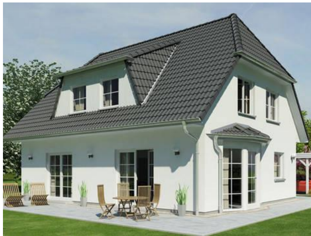
Şekil 9. Dört yüzeyle çolak çatı
