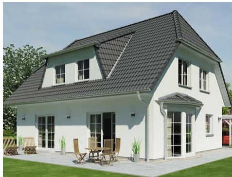
Şekil 5. Dört yüzeyle çolak çatı
