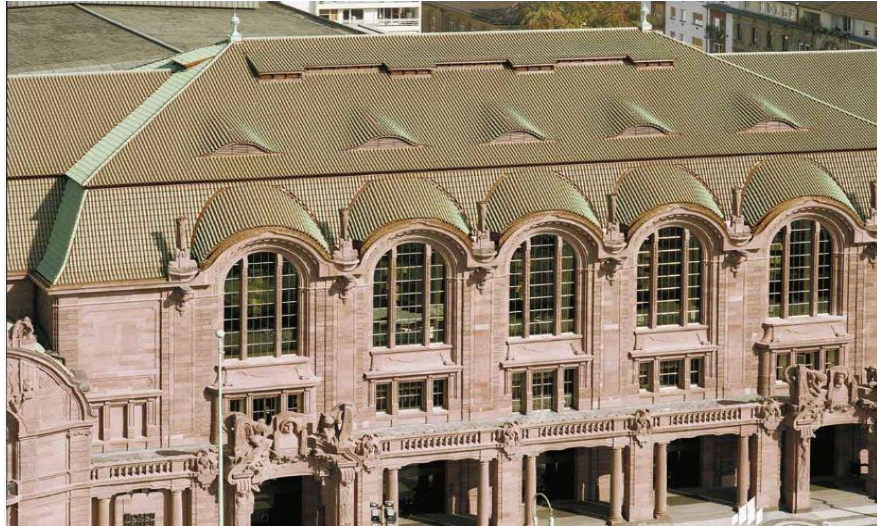
Şekil 24. Çekme, Yarasa ve Tonoz çatı penceresi karma uygulaması
