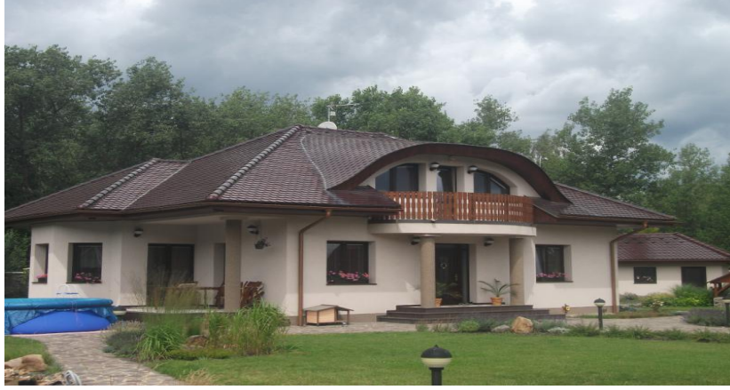
Şekil 27. Turna Balığı şekilli çatı penceresi
