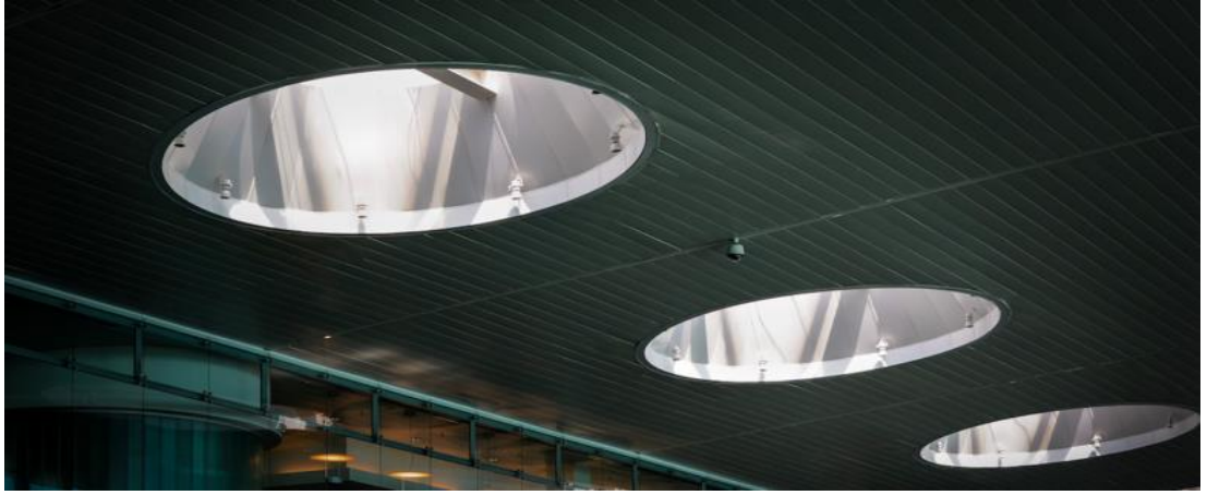
Şekil 30. Güneş tünelleri
