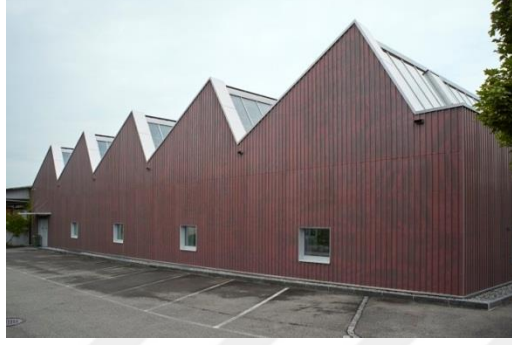
Şekil 2. Testere çatı
