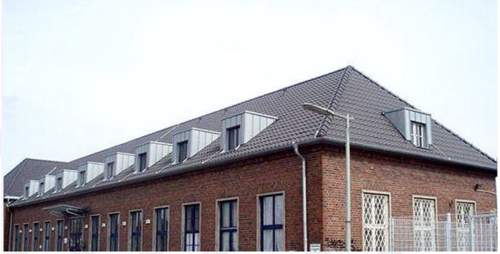
Şekil 29. Düz çatılı çatı penceresi
