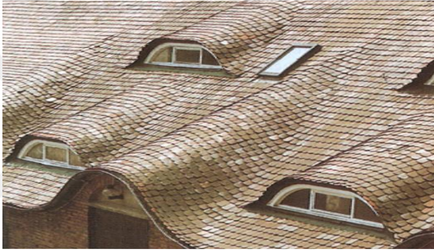
Şekil 25. Turna balığı şekilli çatı penceresi (Müller, 2000)
