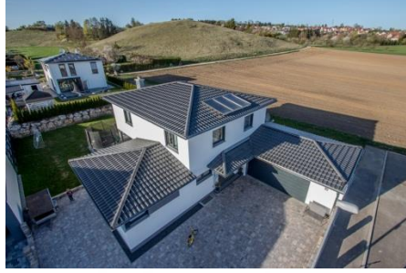
Şekil 8. Dört yüzeyle (kırma) çatı
