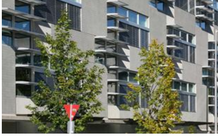
Şekil.3. Güneş ışığının Fazla Etki Ettiği Cephe Yüzlerinde Kullanılan Güneş Kırıcılar ve Ağaçlar
