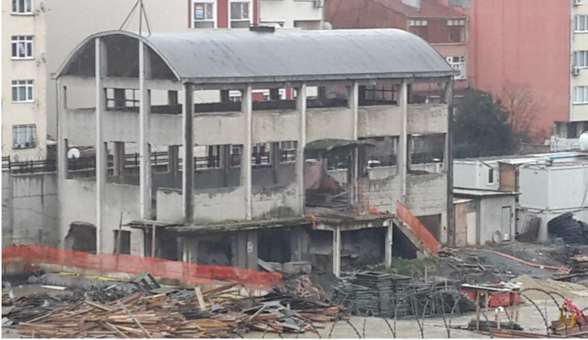
Şekil 28. Hasanpaşa Gazhanesi Dönüşüm Projesi Şantiyeden Görünüş
