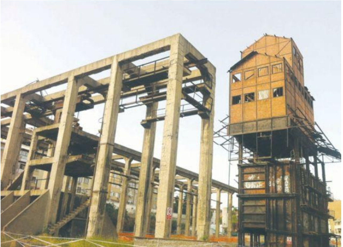
Şekil 26. Hasanpaşa Gazhanesi, Dönüşüm Öncesi Görünüş
