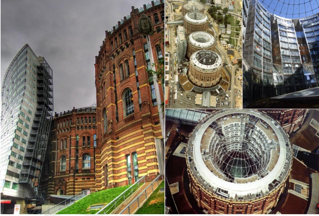
Şekil 5. Viyana Gazometreleri Dönüşümü, Dış Görünüş
