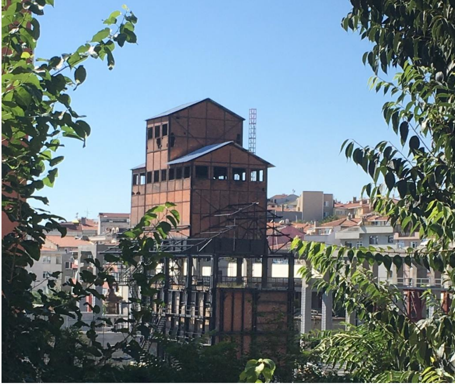
Şekil 46. Hasanpaşa Gazhanesi Dönüşüm Süreci, 2017.
