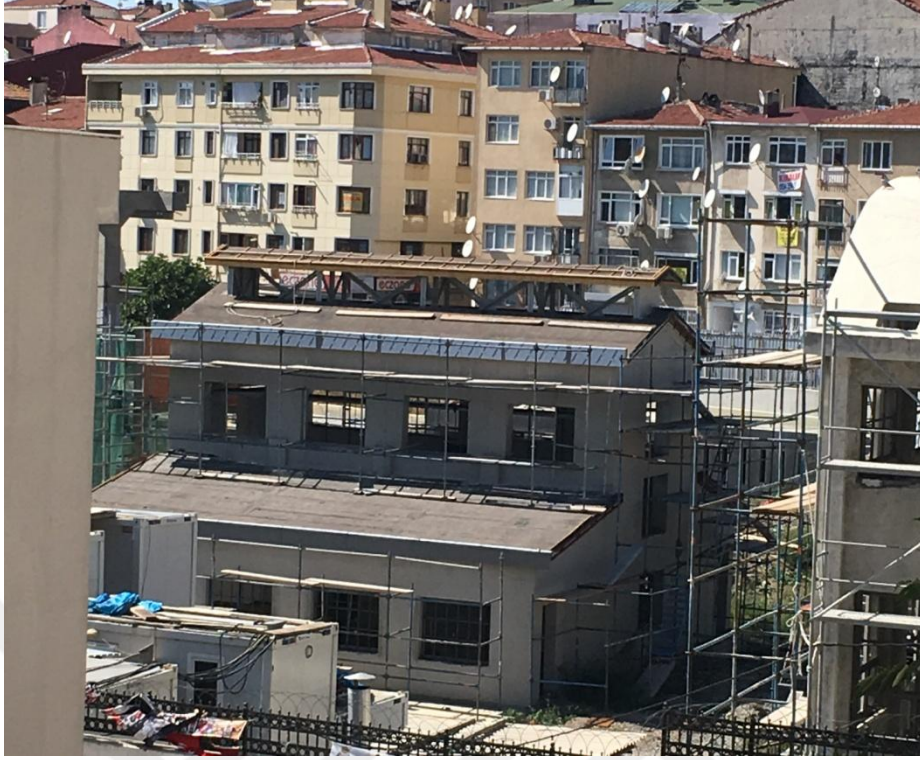
Şekil 47. Hasanpaşa Gazhanesi Dönüşüm Süreci, 2017.
