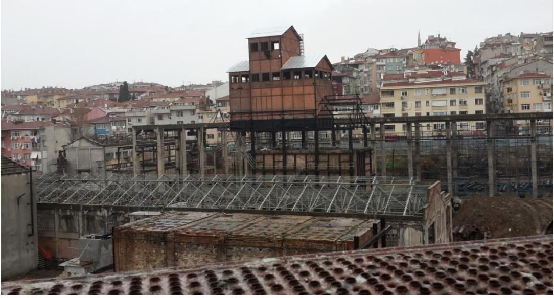
Şekil 43. Hasanpaşa Gazhanesi Dönüşüm Projesi, Şantiyeden Görünüş
