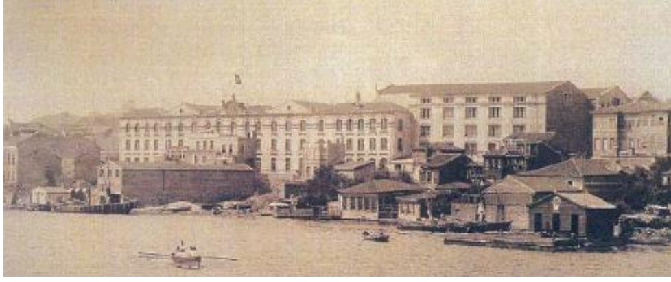
Şekil 61. Dönüşüm öncesi dış görünüş
