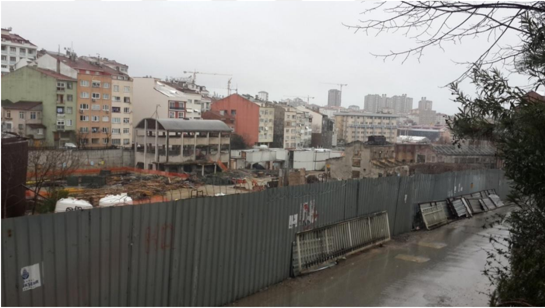
Şekil 44. Hasanpaşa Gazhanesi Dönüşüm Projesi, Şantiyeden Görünüş
