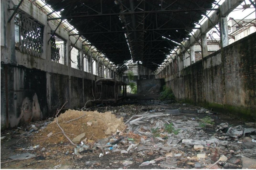
Şekil 32. Hasanpaşa Gazhane Dönüşüm Projesi Sergi Salonu ( http://www.mekanar.com/tr ; 2016).
