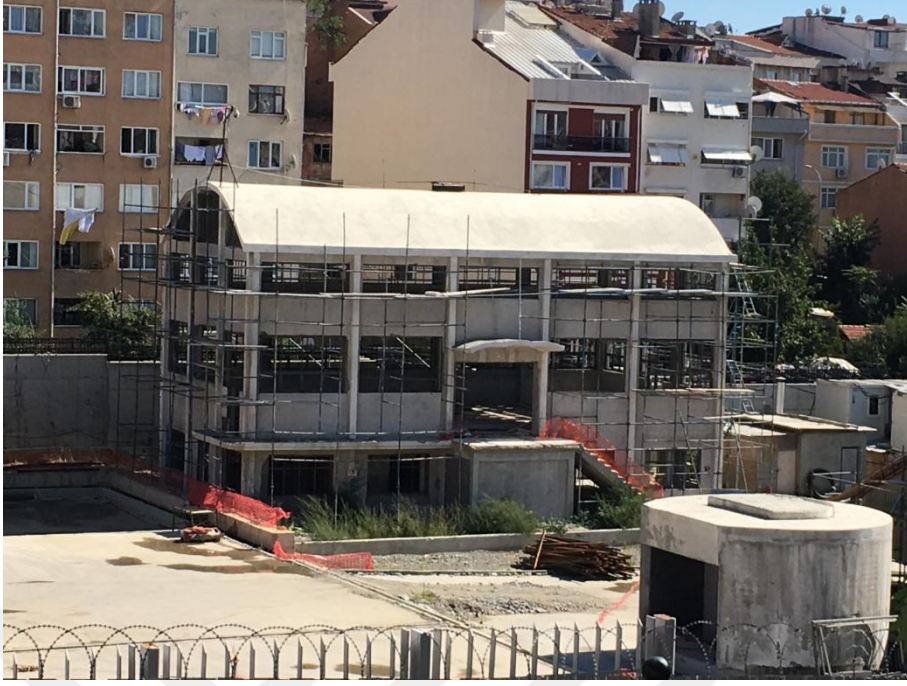
Şekil 45. Hasanpaşa Gazhanesi Dönüşüm Süreci, 2017.
