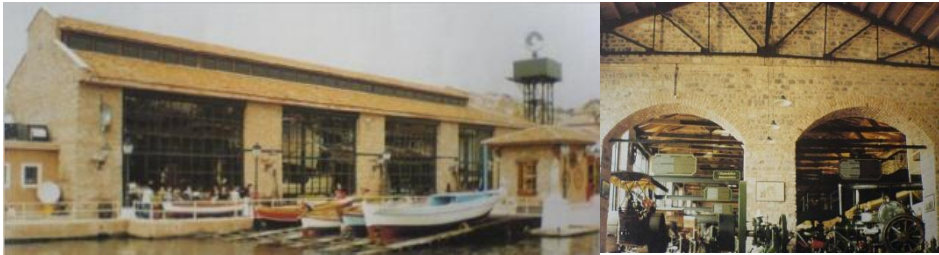
Şekil 83. Rahmi Koç Sanayi Müzesi iç ve dış mekan görünüşler
