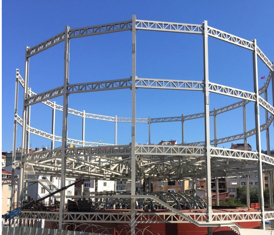
Şekil 48. Hasanpaşa Gazhanesi Dönüşüm Süreci, 2017.
