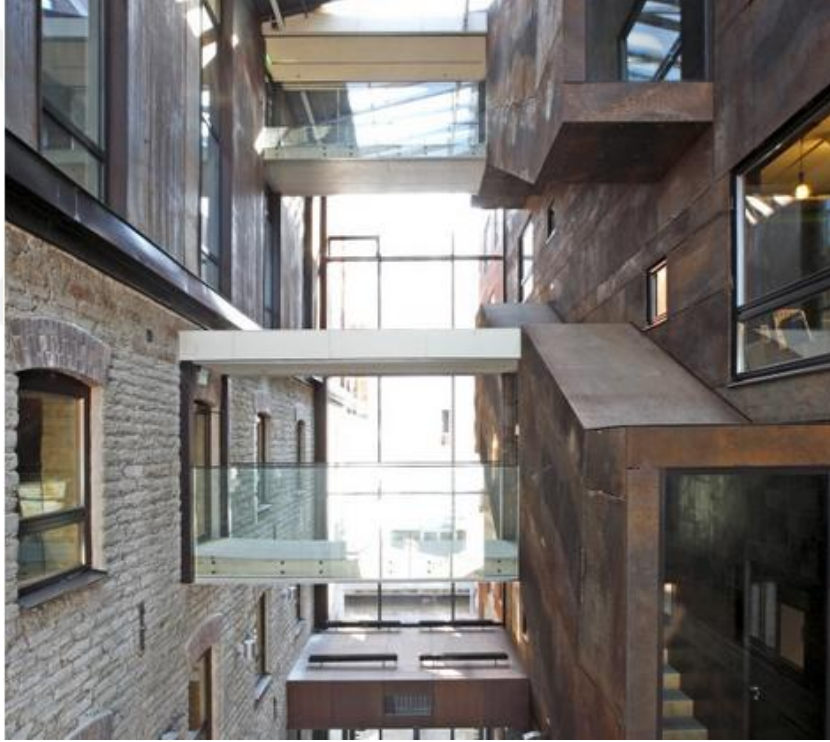
Şekil 18. Rotermann'daki Eski ve Yeni Un Deposunun Dönüşüm Sonrası Görünüşü
