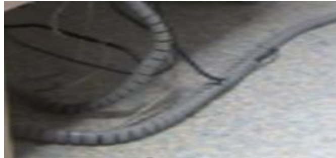
Şekil 6.16. Düzensiz kabloların kablo kanallarına alınması
