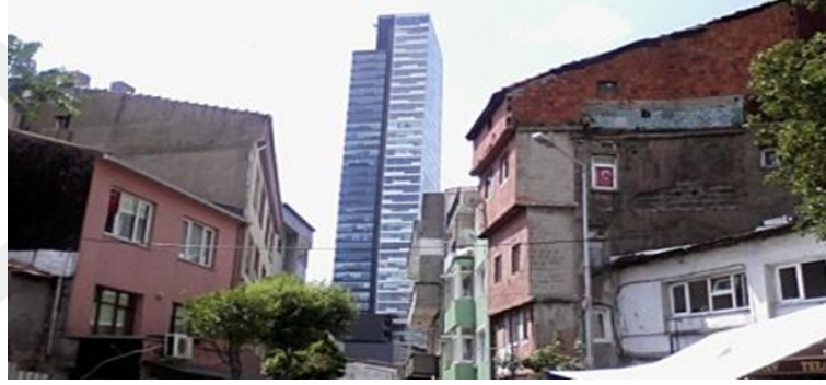
Fotoğraf 29. Var Olan Yerleşim Bölgesinden Trump Towers'a Bakış, Url 41
