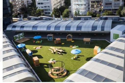
Fotoğraf 26. Akmerkez, Yeşil Çatı, Url 38
