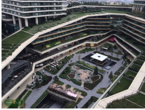
Fotoğraf 39. Zorlu Center Ofis Katları Görünüşü, Url 48
