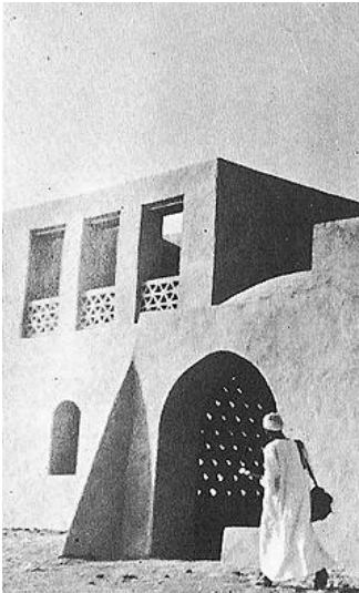
Şekil 26. Mısır'da Hasan Fathy Tarafından Yapılan Yeni Gurna Köyü
