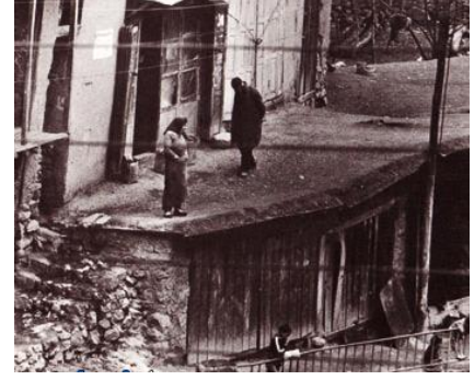
Şekil 58. Masuleh'de Alt seviyede Olan Evin Çatısı, Bir Üst Seviyedeki Sakinler Tarafından Kullanımı
