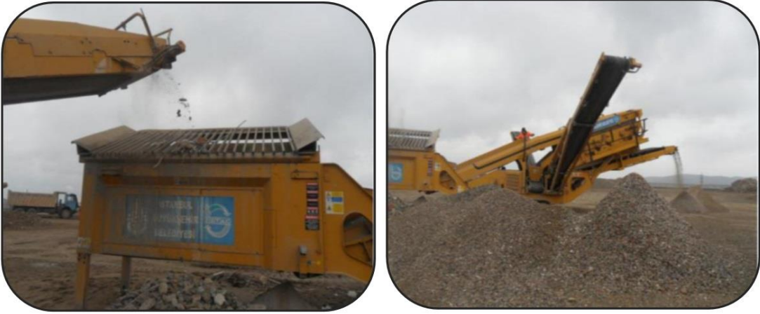
Şekil 19. İnşaat Atıklarının Eleğe Alınması ve Demirin Ayrıştırılması (Karaca, 2012)
