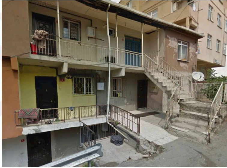
Şekil 5.35. Kontrolsüz Giriş Mekânları: Barbaros Mahallesi (Yeşilyurt Sk., 2016).
