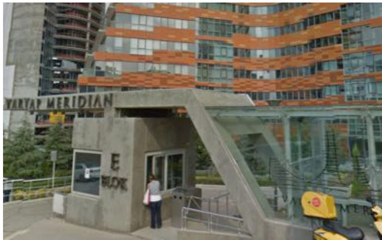
Şekil 5.36. Kontrollü Giriş Mekânları: Varyap Meridian Sitesi (Ahlat Sk., 2016).
