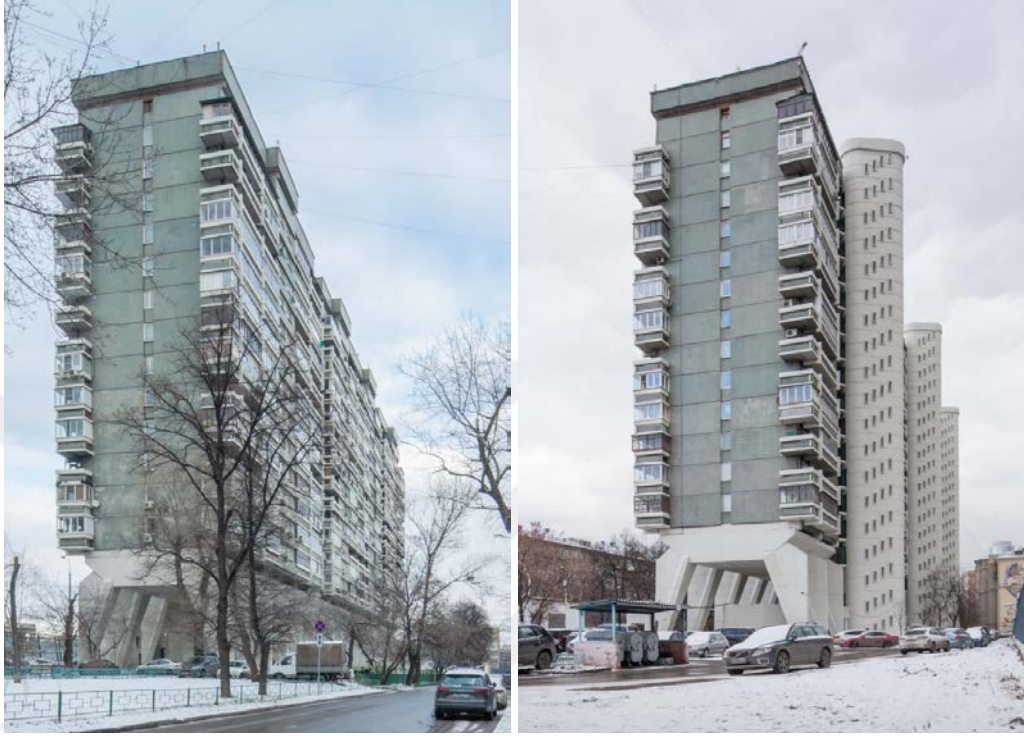
Şekil 16. Moskova Aviators House arka ve ön cephe görünüşü; Andrei Meyerson Kaynak. https://archi.ru/russia/66991/dom-aviatorov-na-begovoi
