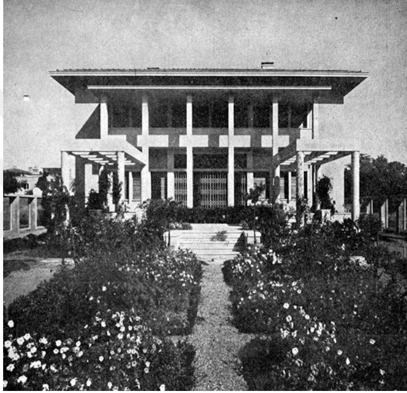
Şekil 50. Salih Bozok Villası görünümü, İstanbul
