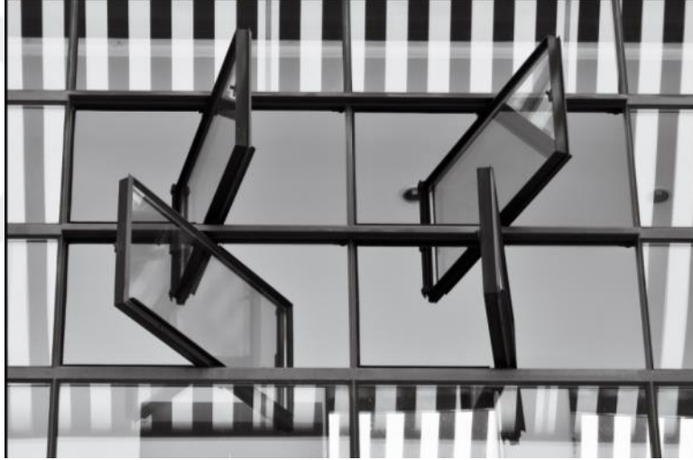
Şekil 25. Fagus Ayakkabı Bağı Fabrikası Pencere Detayı
