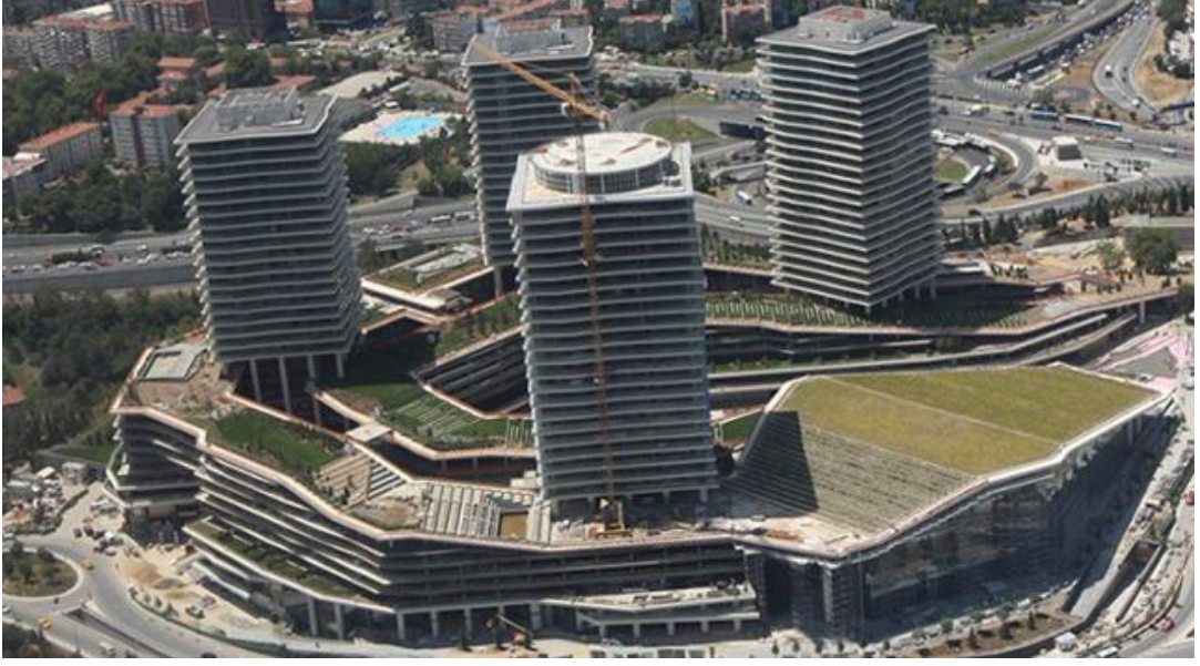
Şekil 17. Zorlu Center Projesi Arazi Yerleşim ve Yeşil Çatı İnşa Süreci (90).
