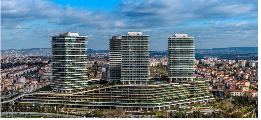
Şekil 16. Zorlu Center Projesi Arazi Yerleşim Fotoğrafı (90).
