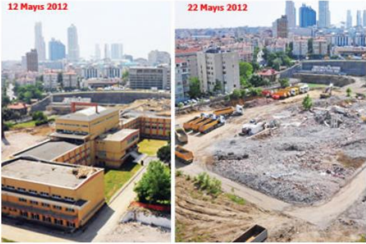
Şekil 2. Quasar İstanbul Projesi'nin Bulunduğu Şişli Likör Fabrikası Arazisi (71).
