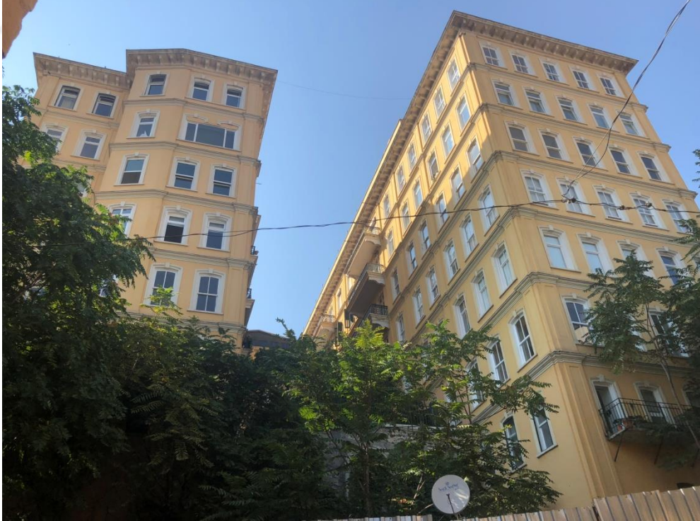
Resim 24. Doğan Apartmanı Arka Cephe
