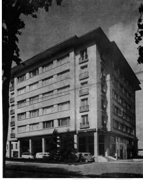
Resim 10. Kervansaray Apartmanı Cephe Görünüşü
