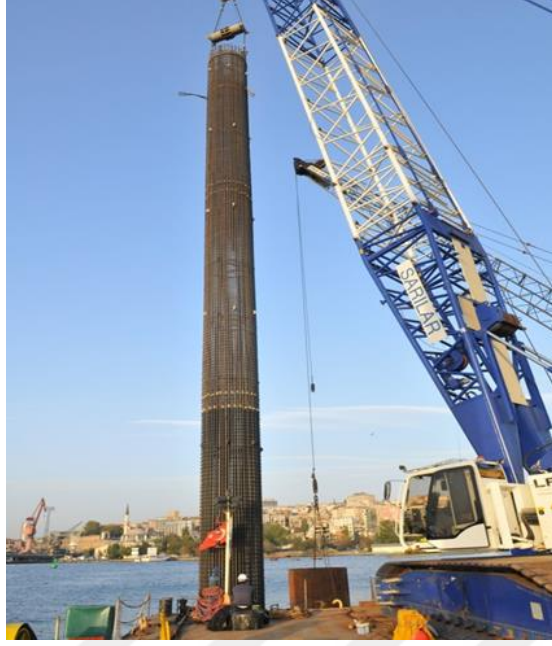
Şekil 15. Donatı kafesinin yerleştirilmesi.
