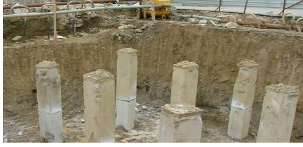
Şekil 5. Kare şeklinde prefabrik kazık çakımı.
