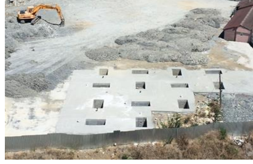
Şekil 28. Betonarme kılavuz duvar.
