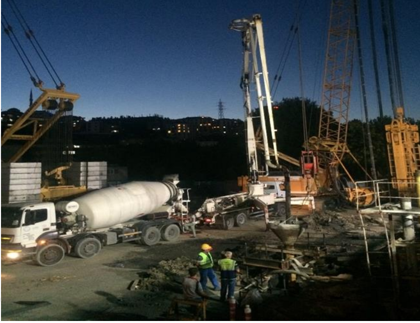
Şekil 33. Beton dökümü.
