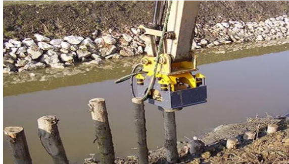
Şekil 3. Ahşap kazık çakımı.
