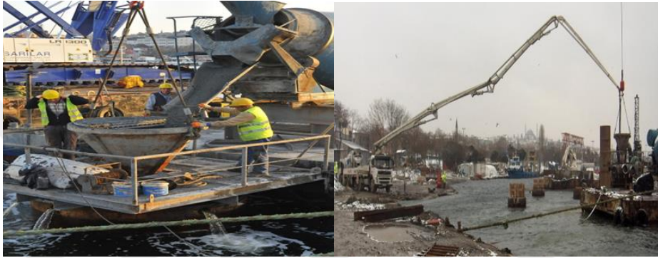
Şekil 23. Beton dökümü.
