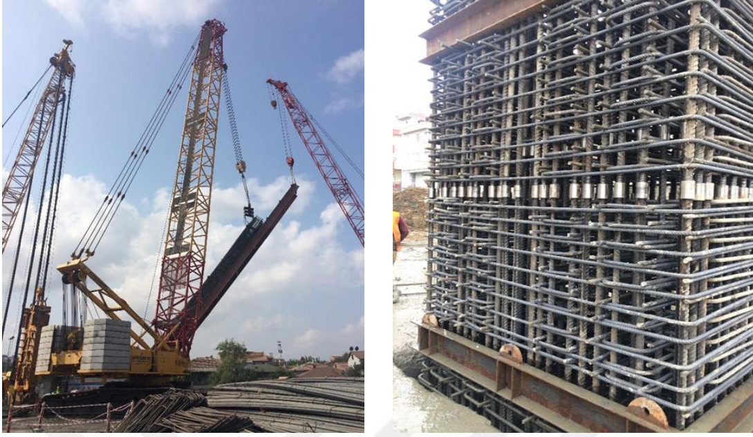
Şekil 31. Baret kazık donatı kafesinin kaldırılması ve manşonlu birleşim.
