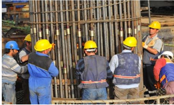
Şekil 16. Kuyu başında manşonlu birleşim.
