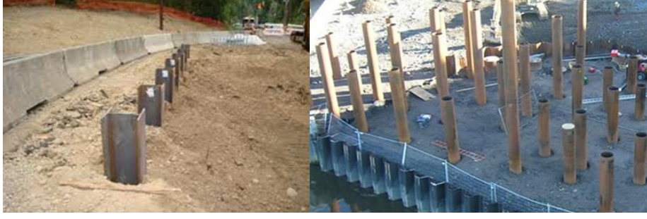
Şekil 6. H ve dairesel kesitli çelik kazıklar.
