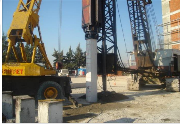
Şekil 4. Prefabrik kazık çakımı.
