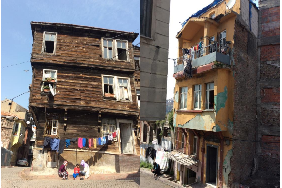
Şekil.6. Mevcut kullanıcı profili ile Yıpranmış yapılar [26]
