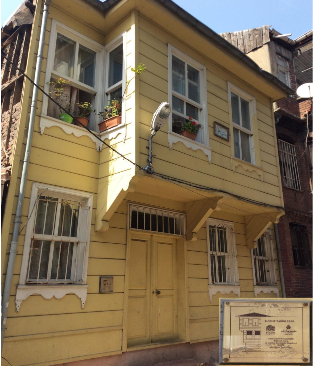
Şekil.21. KUDEB tescilli eser onarım uygulaması [26]
