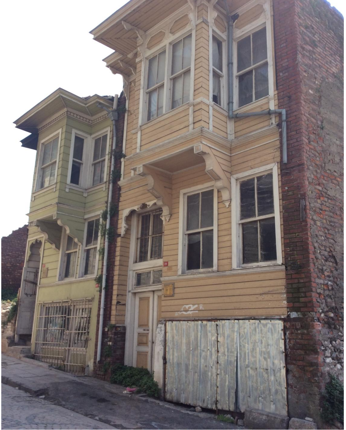
Şekil.22. KUDEB tescilli eser onarım uygulaması [26]
