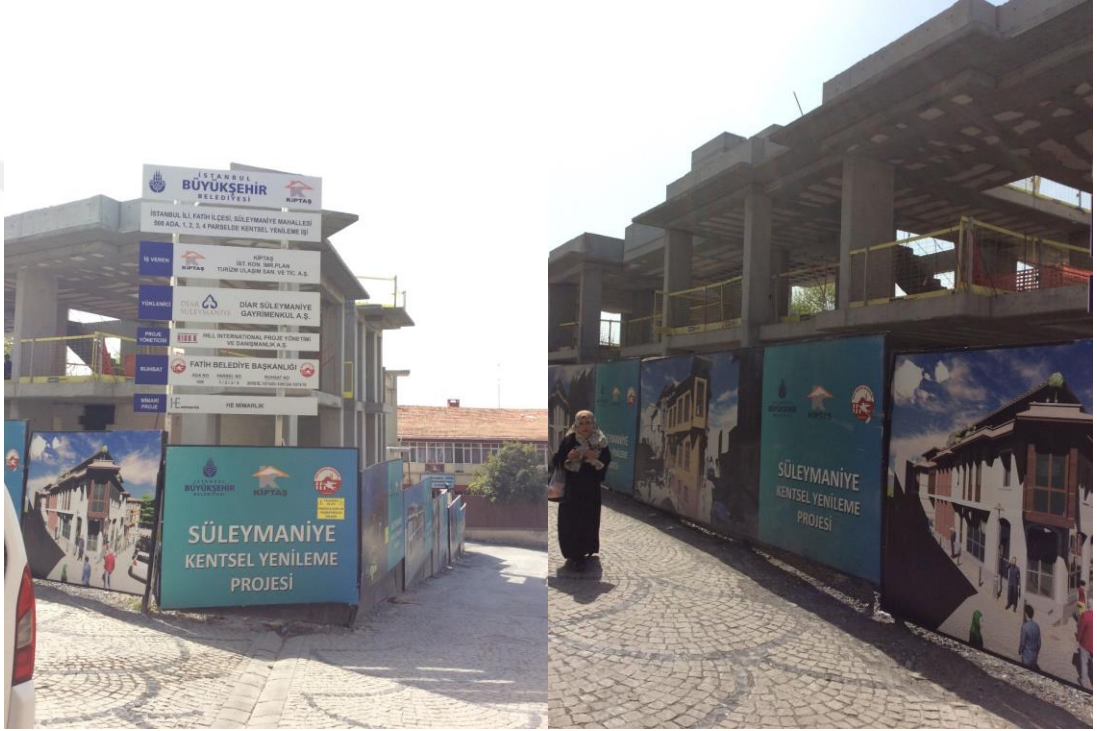
Şekil.51. Süleymaniye yenileme projesi kapsamında inşaat uygulaması başlayan örneklerden [26]
