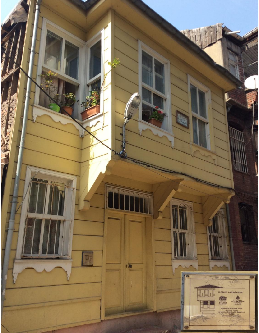
Şekil. KUDEB tescilli eser onarım uygulaması Kaynak: 28.04.20019 Tarihli Berat Uzun Tarafından Yapılan Alan Fotoğraflama Çalışmasından
