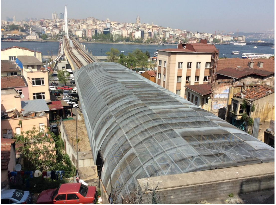
Şekil.20. Haliç Metro Geçiş Köprüsü [26]
