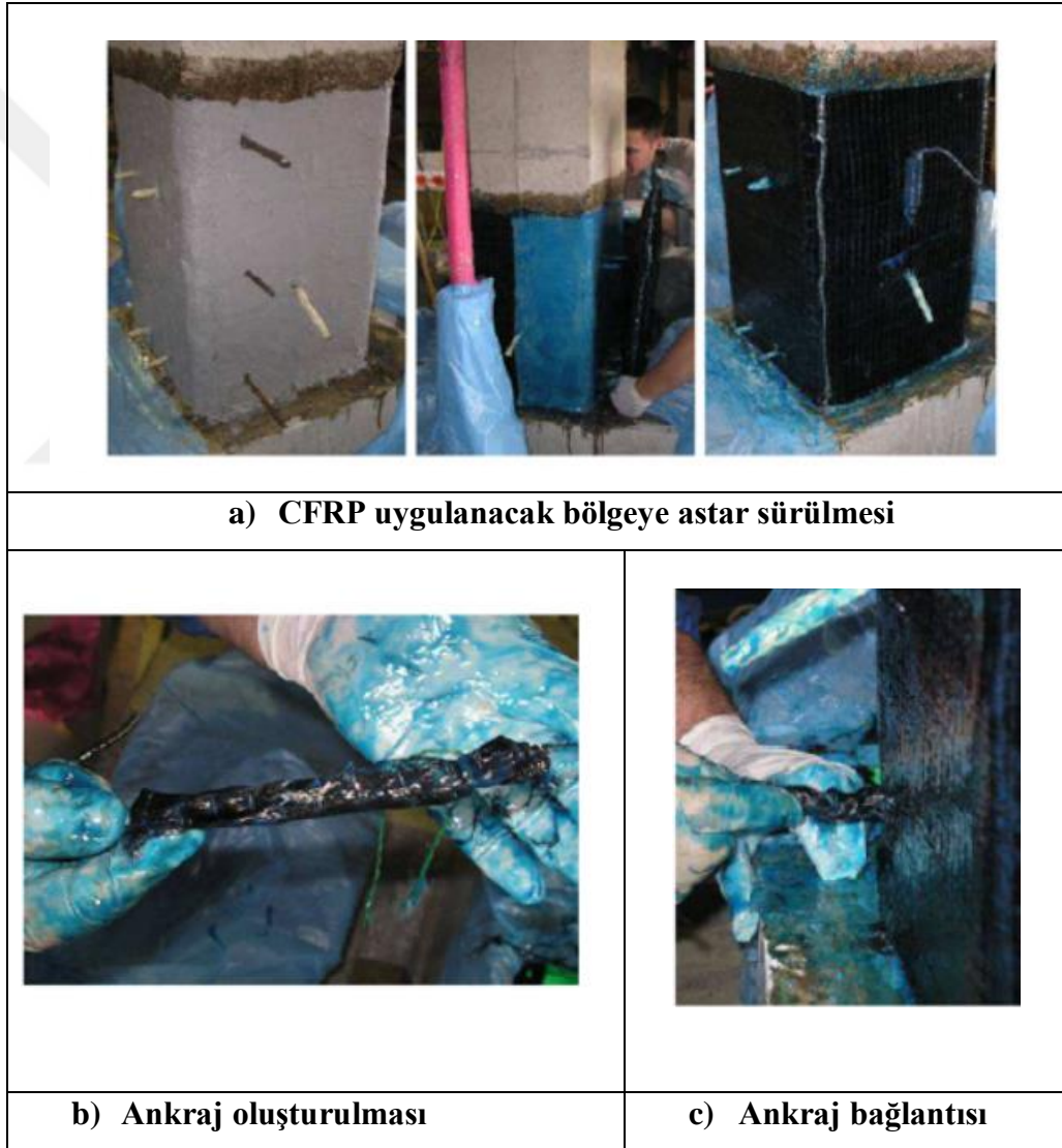
Şekil 6: Tipik bir betonarme kolonun CFRP ile güçlendirilmesi
