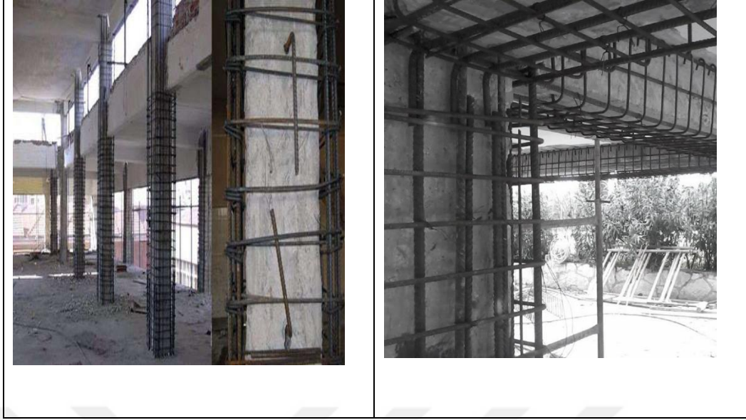
Şekil 1 :Betonarme Mantolama Uygulaması
