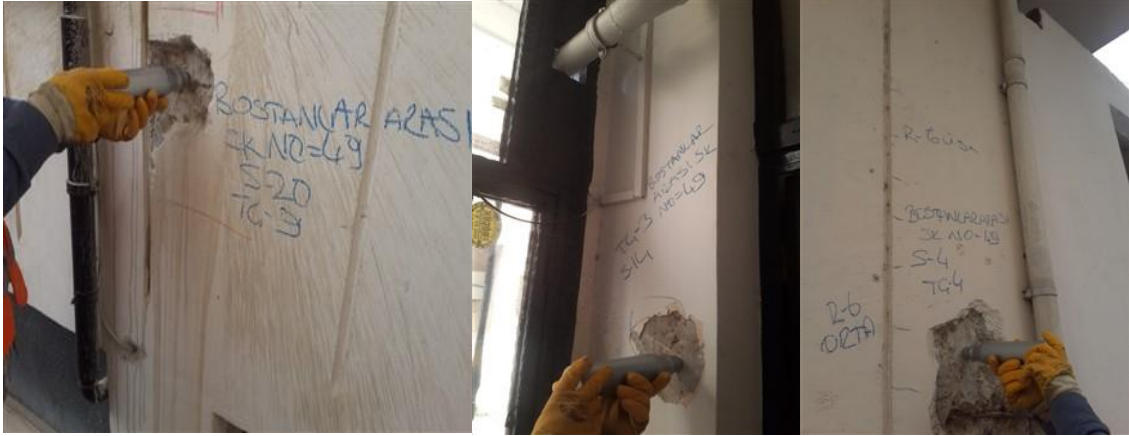
Şekil 4. 15: İncelenen yapının test çekici saha uygulaması örnekleri
