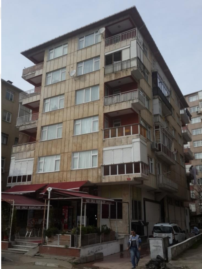
Şekil 4. 1: RYTE' ye göre incelenecek mevcut betonarme yapı
