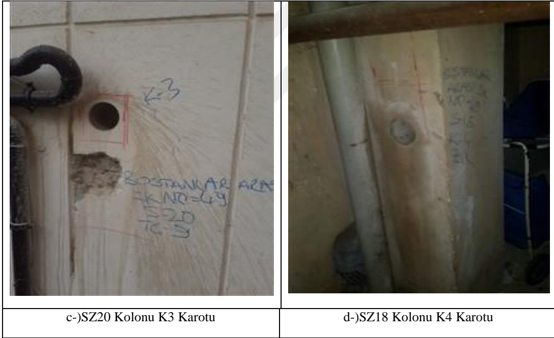
Şekil 4. 17: Karot alınan yapı elemanları (c-d)
